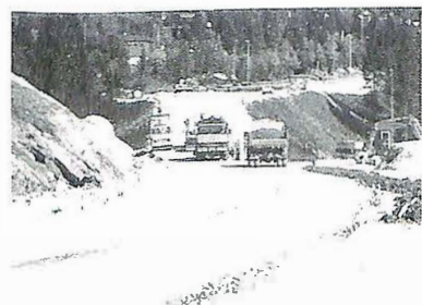
Legging av penetrasjonsdekke mellom Glaskaret og Tertneskryset.
