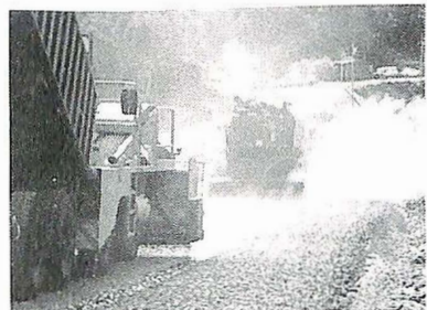
Legging av penetrasjonsdekke mellom Glaskaret og Tertneskryset.
