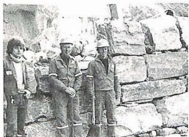
Muringsarbeid ved Glaskartunnelen. Fra venstre: en privat maskinkjører, vegvesenets Mons Hauge og Kjell Mosevoll.
