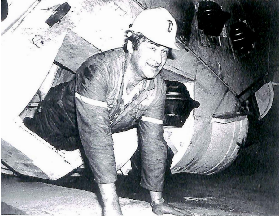
Sigbjørn Smådal demonstrerer «smutthullet» der man kommer seg fram for å skuite kultere på borehodet.
