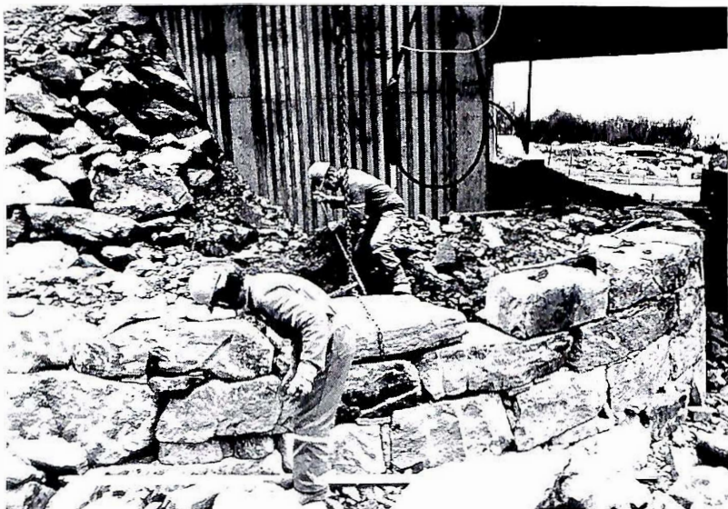
Arvid og Birger Reigstad tek i for å få steinen på rett plass i muren under Øyjords-viadukten.
