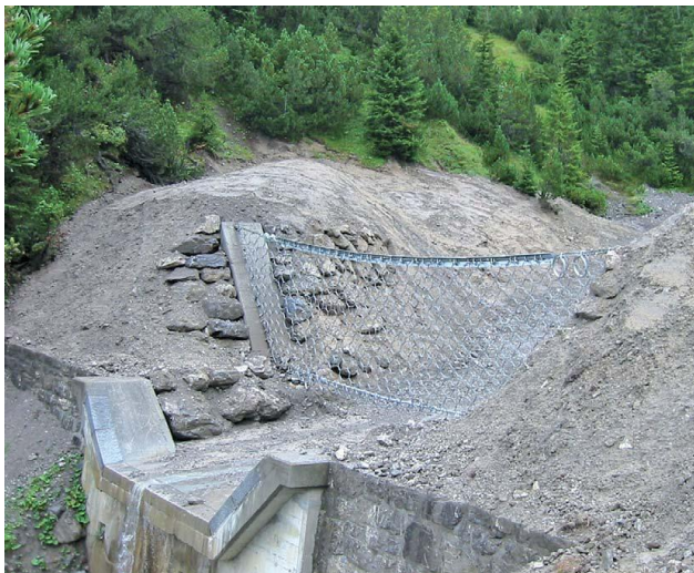
Figur 6.26. Eksempel på bruk av fleksibelt nett i en åpen kontrolldam. (Foto: Geobrugg AG)
