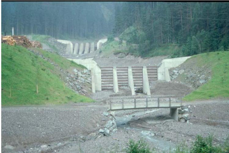
Figur 6.23. Eksempel på to typer åpne kontrolldammer. Lienz, Østerrike. http://step.ipgp.fr/images/e/e3/09_02_Debris_Flow_Mitigation.pdf
