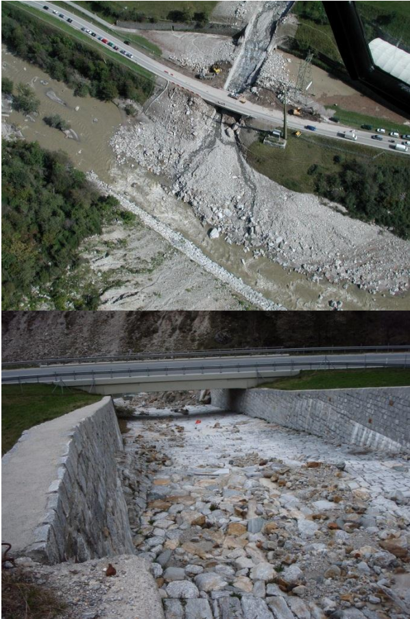
Figur 6.18. Bygging av bru og ledemurer for å styre skredmassene under vegen, Ponte Rossa, Biasca, Sveits, Foto: Giorgio Valenti, Canton Ticino (venstre) og Harald Norem (høyre).
