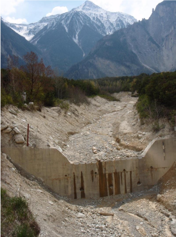
Figur 6.7. Eksempler på kontrolldammer i skredløp for å redusere massetransporten og øke energitapet langs skredløp, Illgraben, Sveits (Foto: Harald Norem).
