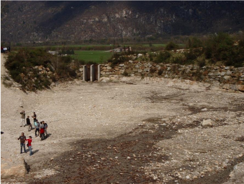
Figur 6.27. Eksempel på kombinasjon av sedimentasjonsbasseng og åpen kontrolldam. Biasca, Sveits. (Foto: Harald Norem)
