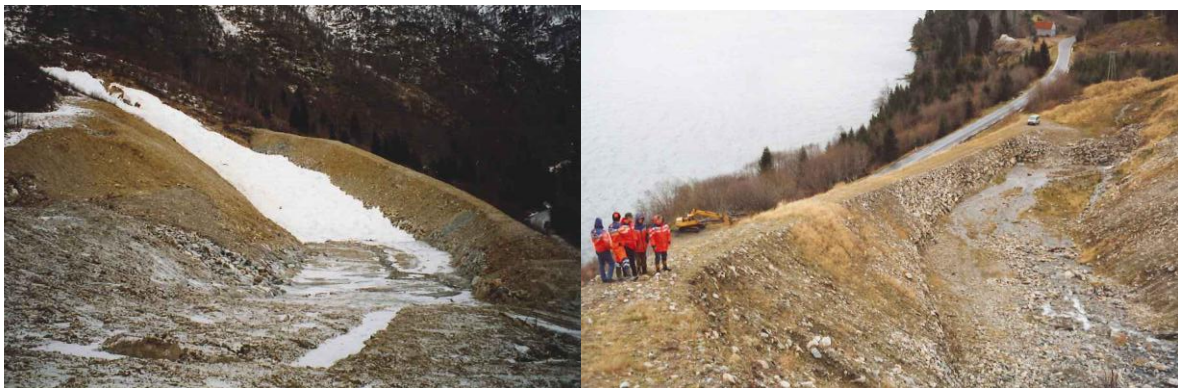
Figur 6.12. Eksempel på ledevoll for sikring mot snøskred og sørpeskred. Vollkrona er dessverre ikke bygget med jamn stigning i øvre delen av vollen, og på dette partiet har skred gått over vollen, Sandvika, Sogn og Fjordane (Foto: Harald Norem)
