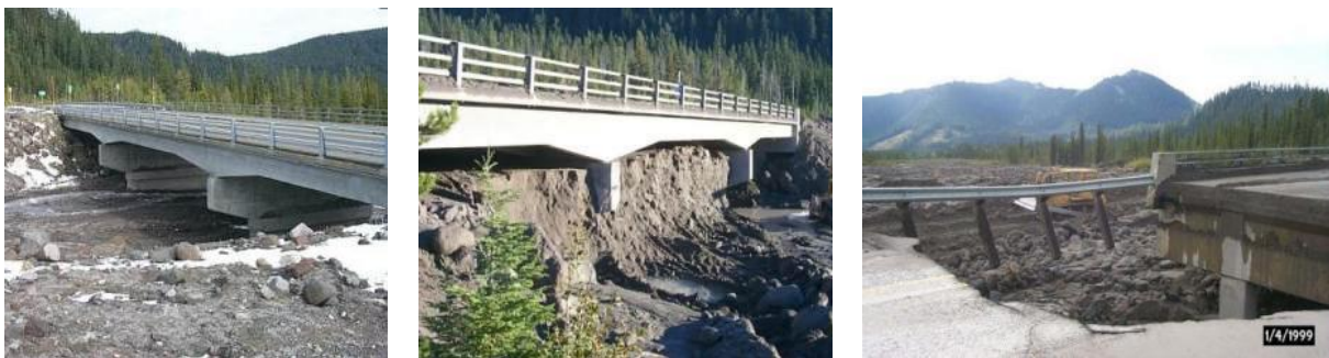
Figur 6.22. Foto av bru hvor skredet har stoppet opp under brua. White River Bridge, Oregon. (Armstrong et al).
