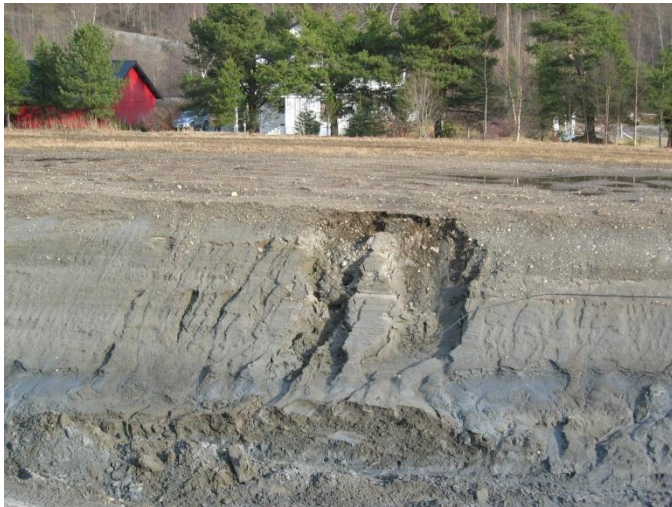
Figur 2.3. Eksempel på overflateskred som skyldes erosjon der det har vært stor vannstrømming langs permeable lag. E6, Melhus, Sør-Trøndelag. (Foto Ivar Horvli)
