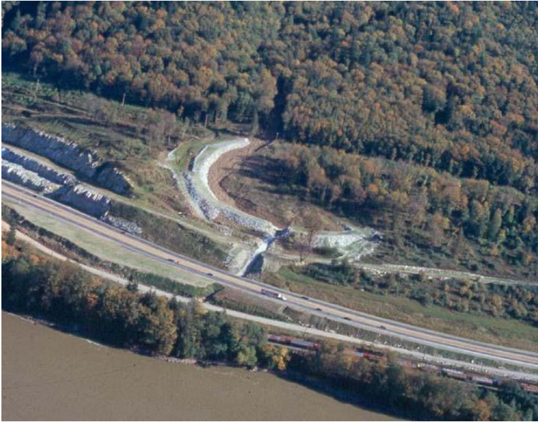
Fig 6.28 Eksempel på en ledevoll/fangvoll og sedimentasjonsbasseng fra Chilliwack, B.C., Canada. Flomvannet og de finere materialene føres fram til kulverten for vegen gjennom en åpen kontrolldam og utsprengt flomløp.
