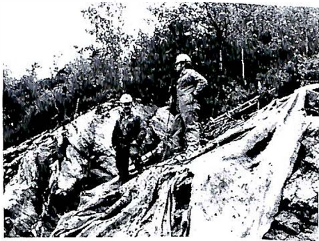
Charles Hartveit og Svein Engstrøm dekkjer til salva før sprenging.
