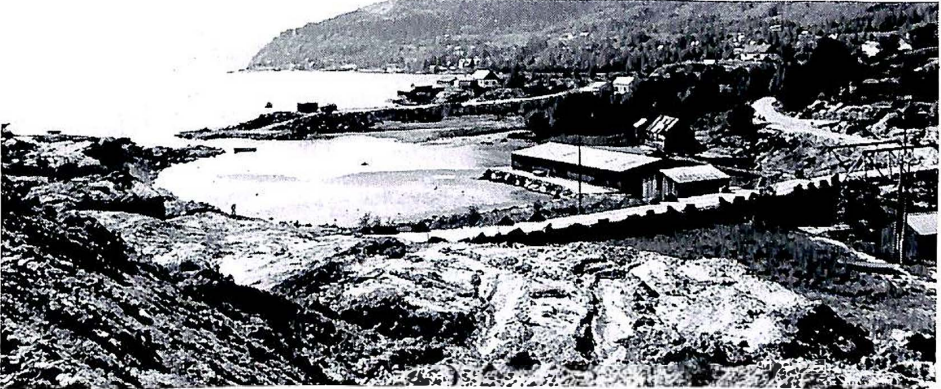
Oversikt over ein del av anlegget i Eikelandssosen. Fyllinga midt i biletet, kombinert med bru, skal erstatte den gamle, smale brua over Koldalsosen, som held for dårleg akseltrykk. Nyevegen skal gå vidare opp mot staden der biletet er teke. Gamlevegen vil bli gjort om til gangveg, opplyste anleggsleiar G. Tunestveit under synfaringa.
