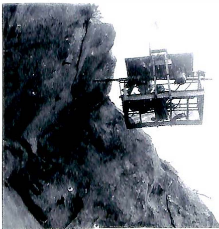
Bolting av fjellet, høyt over vegbanen. Renskelaget Dyrset, Markhus og Sævareid tok seg av dette arbeidet.
