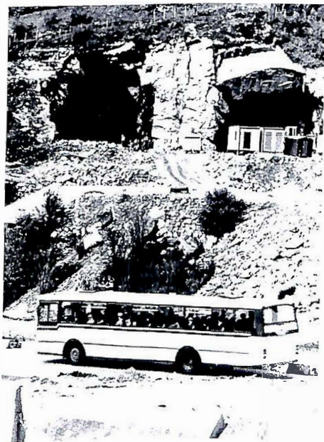
Få anlegg ligg så lett synleg for folk flest som Eidsvåg—Øvre Ervik, der dei som skal trafikere vegen i framtida så å seie dagleg kan følgje med i kva som skjer på anlegget. (Foto: VA.)
