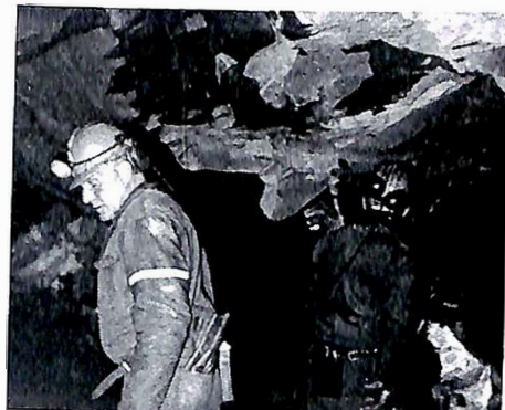
Oscar Bystøl og Anders Jordalen i gang med reinskearbeid før boring til siste salva i Austmannali-tunnelen. (Foto: R. Myrmel)
