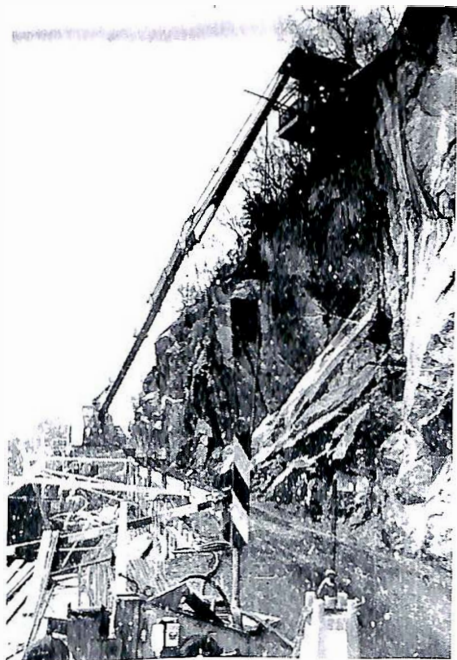
Forskalingsarbeidet er kommet i gang på nedsiden av vegen.
