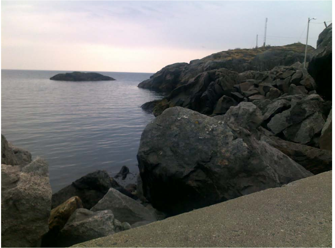
Figur 3 Bilde tatt fra Rundkulten og sørover. Med unntak av holmen Skarven som sees i bakgrunnen er det i denne retningen åpen sektor ut Vestfjorden. Blokkene på dette punktet er noe større enn på foregående bilde, men fyllingens tilstand viser at det er store bevegelser i blokkene. I høyre billedkant skimtes en blokk på anslagsvis 5 – 6 tonn som er blitt plassert oppå betongkanten av bølgene. Betongmuren i forgrunnen synes å ha blitt satt opp for å beskytte mot overskylling.
