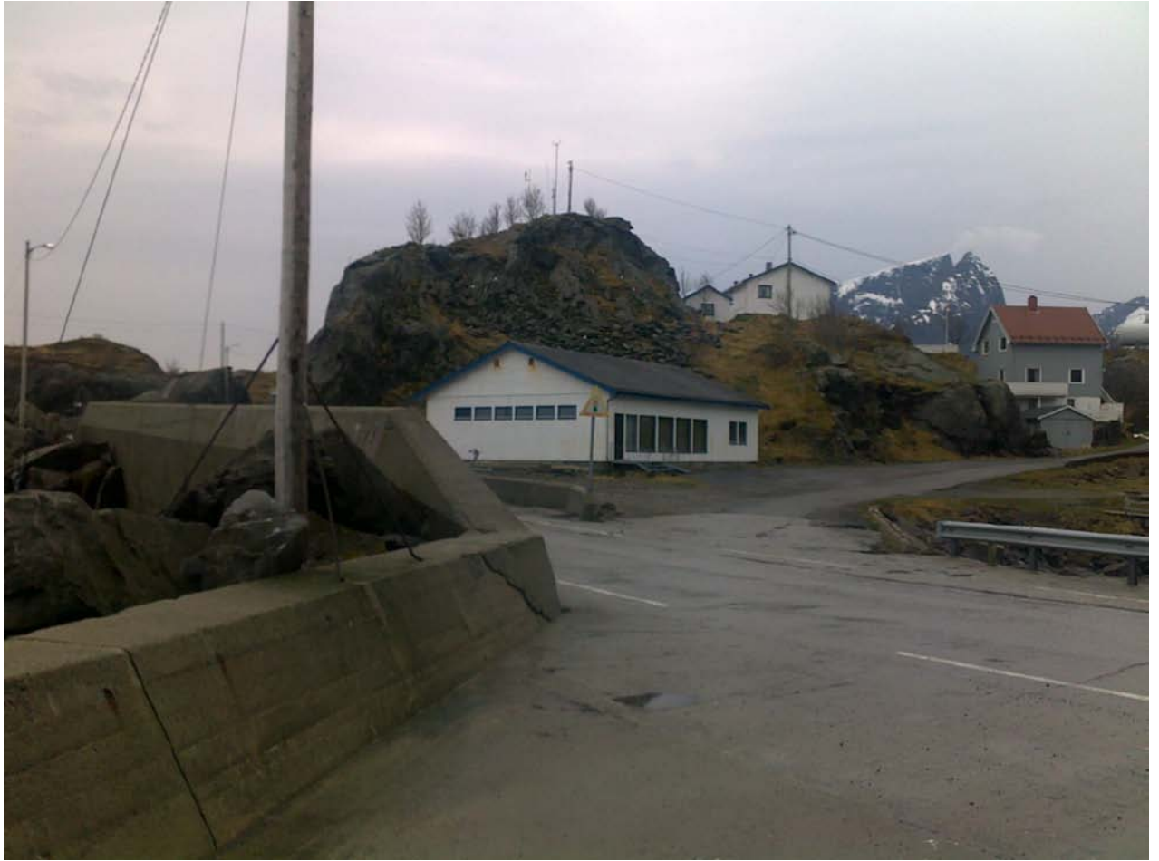
Figur 4 Bilde tatt fra samme posisjon som det foregående (sør for Rundkulten) i retning sørøst. Betongmuren som beskytter mot overskylling er tydelig. Etter lokale opplysninger skal den nærmeste bygningen ved en anledning ha blitt sterkt skadet av bølger.
