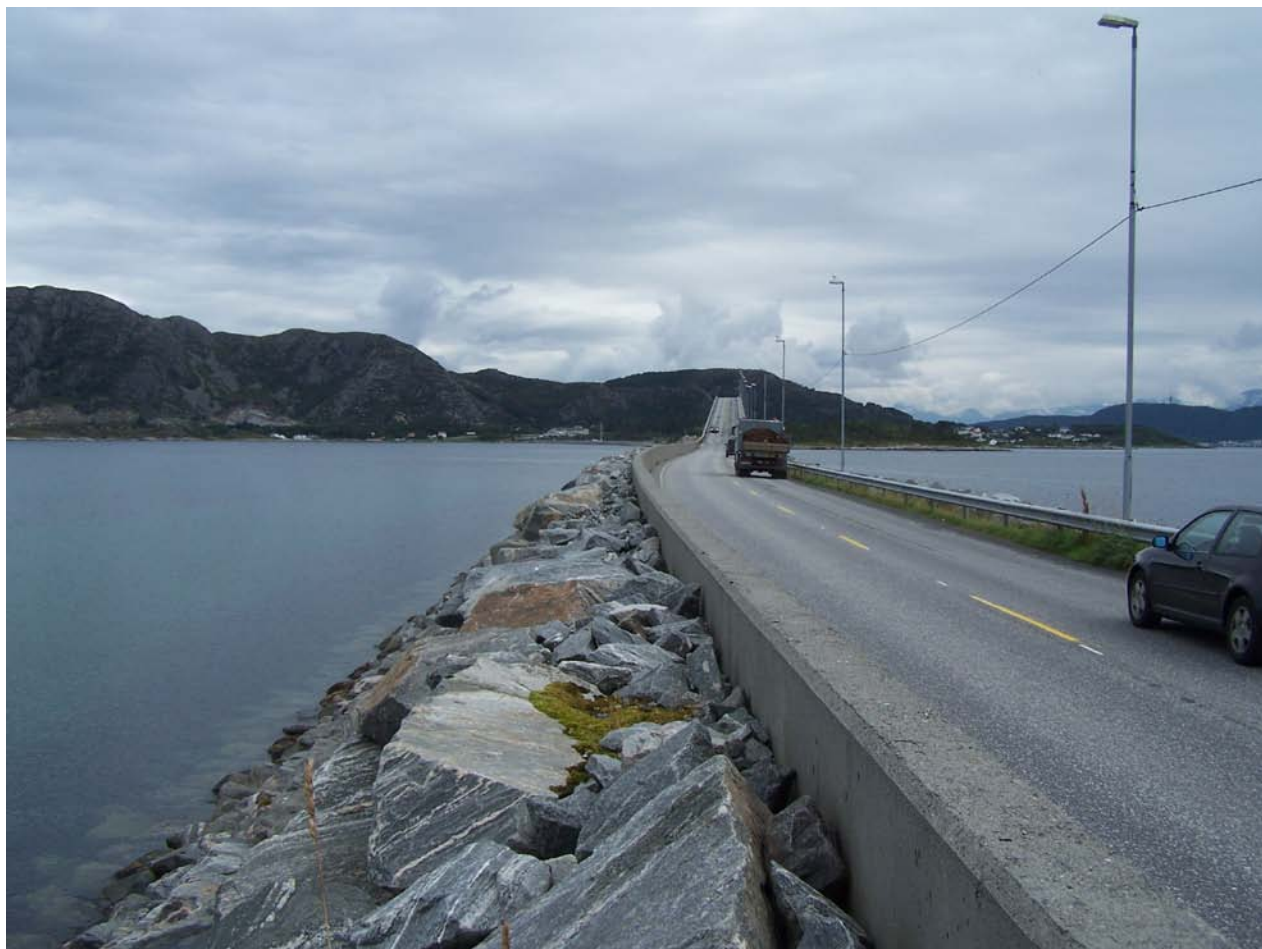
Figur 9 Utsikt fra Giske mot Valderøya (retning øst). Brua sees i bakgrunnen, og betongkanten som ble bygget i 1990 sees til venstre for vegbanen. Betongkanten er 1.25 m høy.
