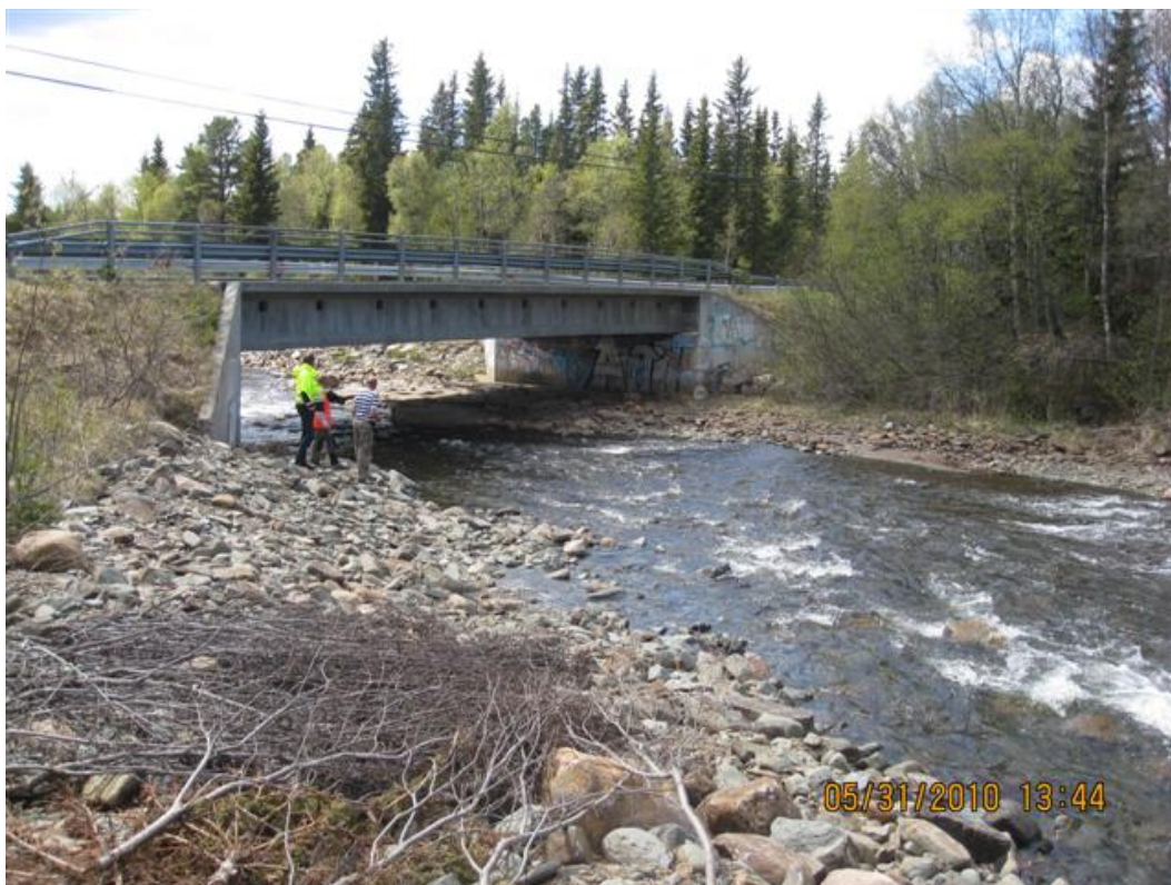
Bilde 22. Bitu bru på Fv.H-362 fra oppstrøms side (Foto: B. Dolva).
