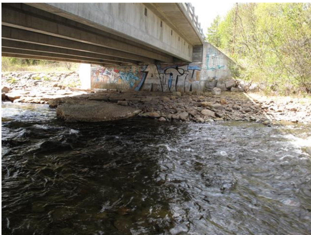
Bilde 23. Bitu bru på Fv.H-362 – landkar i retning Raulandsgrend (mot vest) med deler av opprinnelig erosjonssikring intakt (Foto: O. Lahus 31/5-2010).
