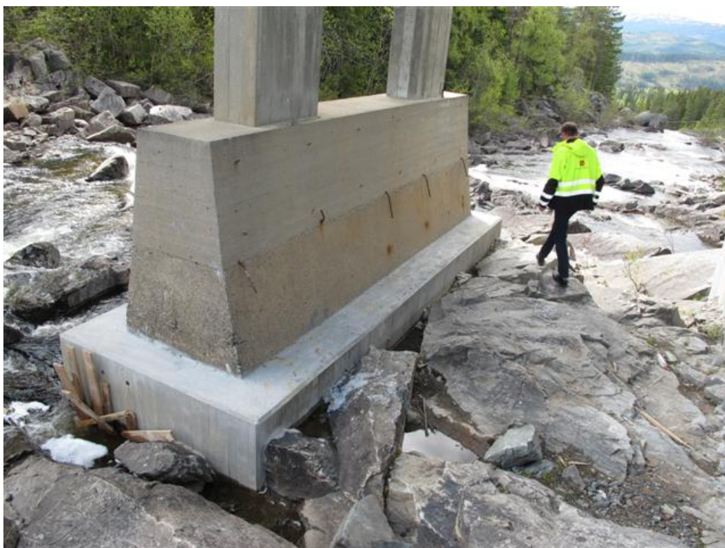
Bilde 8. Hylland bru på Fv. H-037 – detalj fra søylefundament sett fra oppstrøms siden i retning mot Åmot (Foto: O. Lahus 31/5-2010).
