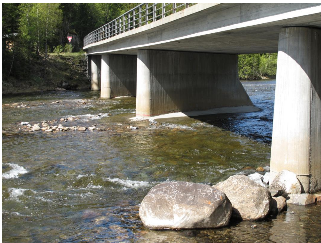
Bilde 2. Vinje bru på E134 – sett fra nedstrøms side (Foto: B. Dolva).
