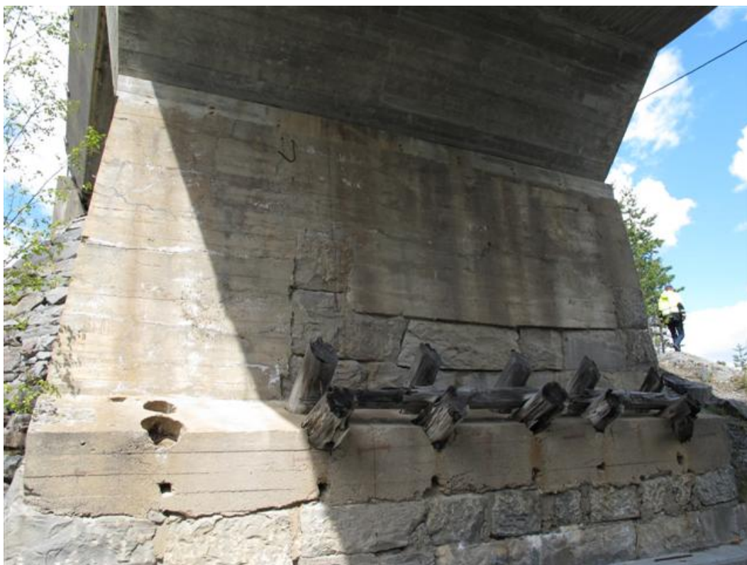
Bilde 7. Hylland bru på Fv.H-037 – detalj fra landkar på siden mot Åmot. (Foto: O. Lahus 31/5-2010)
