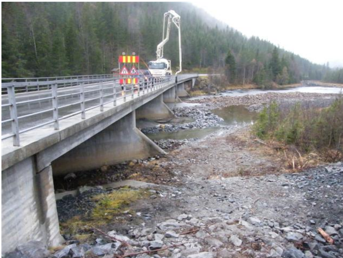
Bilde 2. Utstøping i akse 2 Vinje bru på E134 (Foto: A. Kåsa 3/11-2009)
