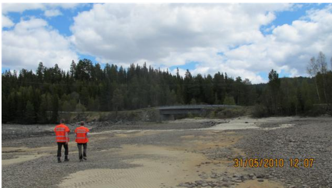
Bilde 15. Tanselv bru på Fv. H-037 – sett fra nedstrømsside ved utløpet i Totak (Foto: B. Dolva).
