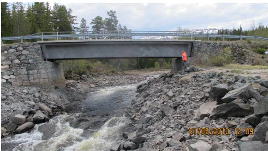
Bilde 19. Tanselv bru på Fv.H-037 – sett fra nedstrøms side (Foto: B. Dolva).
