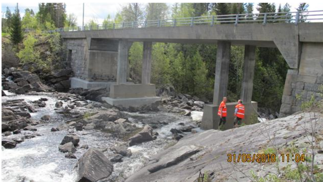
Bilde 5. Hylland bru på Fv.H-037 – sett fra oppstrøms side (Foto: Dolva).
