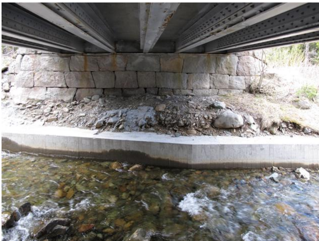
Bilde 13. Stavså bru på Fv.H-037 – detalj fra landkaret på sydsiden, med 2 generasjoner utbedringer (Foto: B. Dolva).
