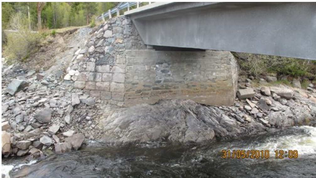
Bilde 17. Tanselv bru på Fv.H-037 – landkar nord sett fra nedstrøms side (Foto: B. Dolva).
