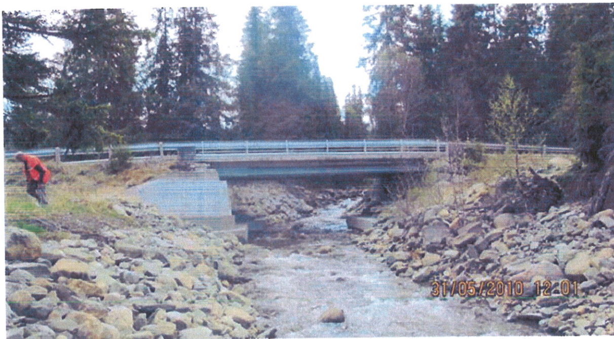
Bilde 11. Stavså bru på Fv.H-037 – sett fra nedstrøms side (Foto: B. Dolva).
