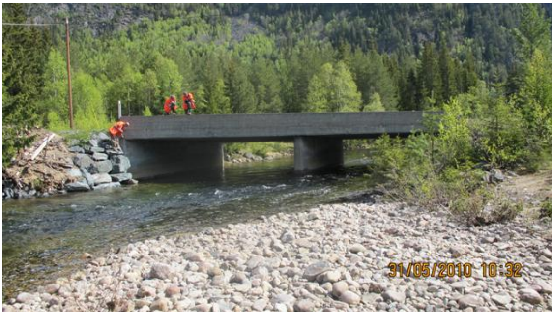
Bilde 3. Ruså bru på E134 – sett fra oppstrøms side (Foto: Dolva).
