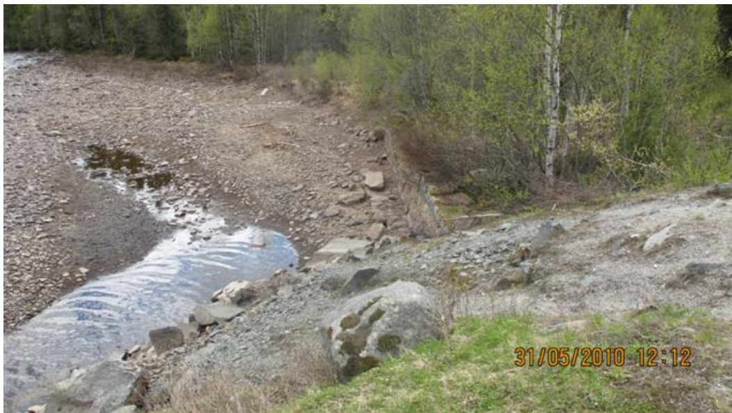
Bilde 21. Deler av elveløpet og gammel (lede-)mur på oppstrøms side av Tanselv bru på Fv.H-037 (Foto: B. Dolva).
