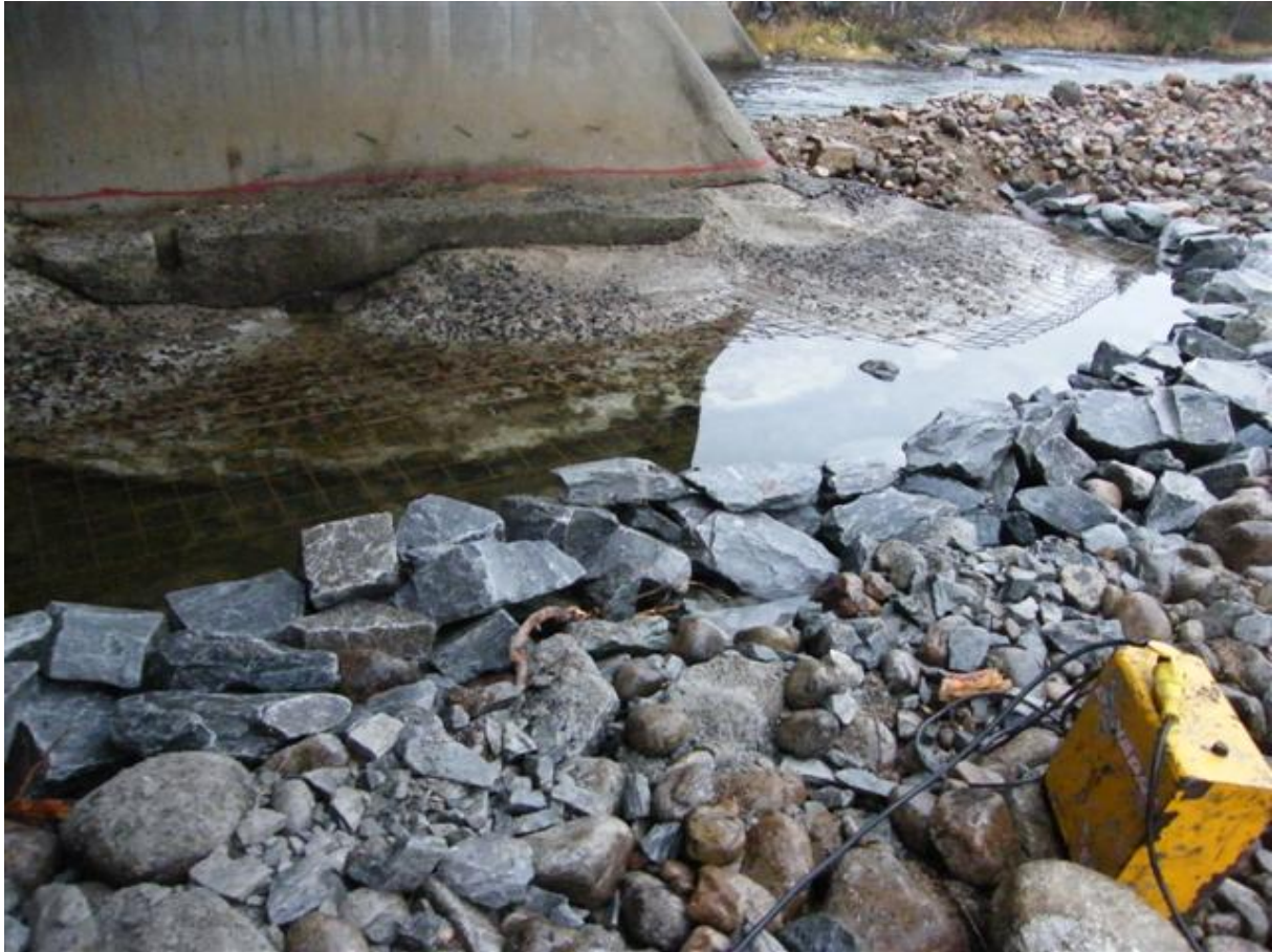
Bilde 1. Forberedende arbeider før utstøping i akse 2 Vinje bru på E134 (Foto: A. Kåsa 3/11-2009)
