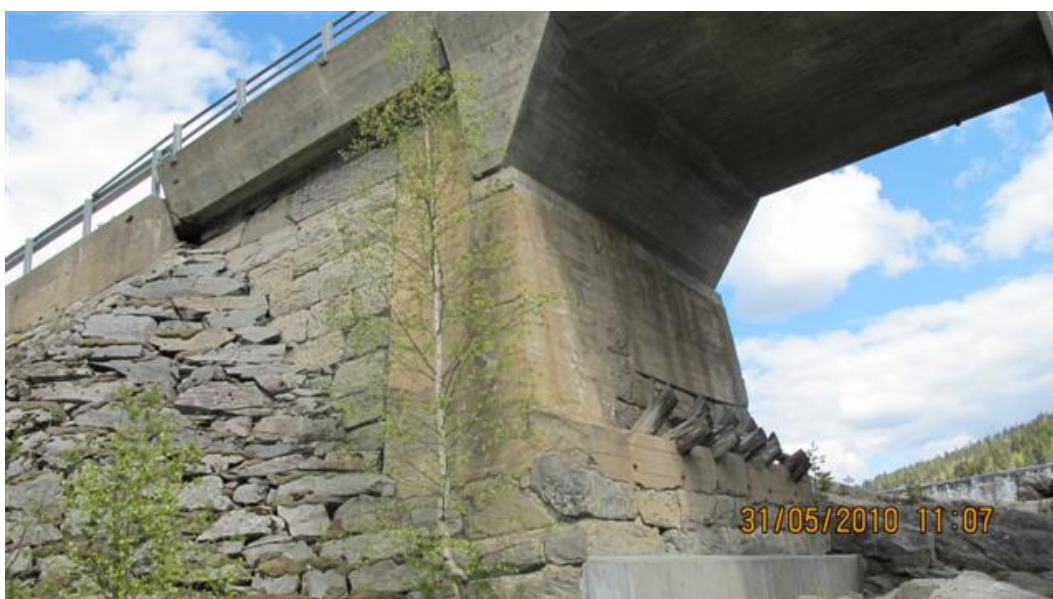
Bilde 6. Hylland bru på Fv.H-037 – Landkar på siden mot Åmot - sett fra nedstrøms side (Foto: Dolva).
