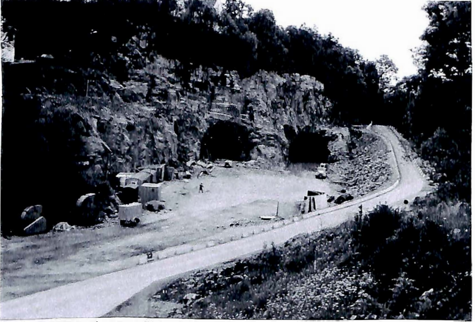
Oversiktsbilete frå Hopssida med dei to tunnelinnslaga. Det er tunnelen til høgre som i første omgang skal gjerast køyrbar. Vegen framme på biletet er mellombels, den skal leggjast på portalane over dei to tunnelane.
