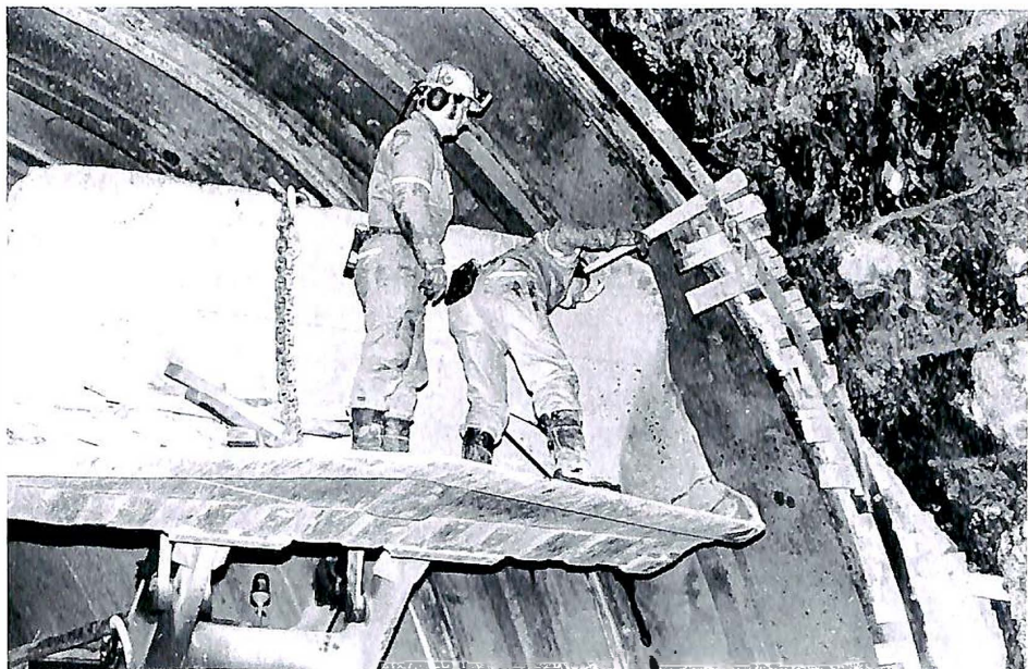
Etterarbeidene blir ofte for dyre, er en av konklusjonene i rapporten. Her brukes betong i Haukanestunnelen.
