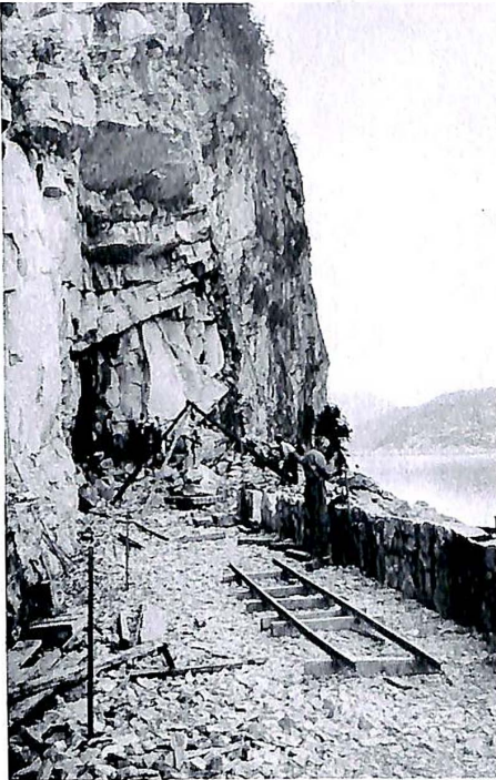
Fra arbeidet med innslaget til Høgberg-tunnelen, sett fra Eidslandsiden.
