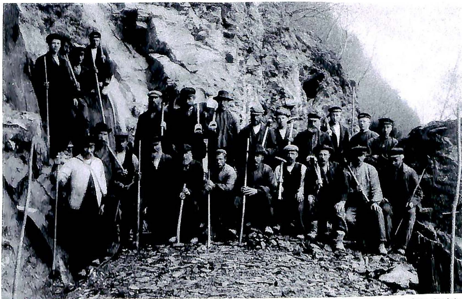
Vegarbeidsfolk i Bergsdalen kring 1900. Det kan nemnast at arbeidarane måtte halde spadar sjølv på denne tida.
