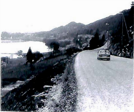
Ny Rv. 560 og E 68 omkring Arna gjer tilværet tryggare for Arna-buar. og gjennomkøyringa lettare for trafikantar. Biletet syner den nye vegen mellom Ytre og Indre Arna, som ein ser i bakgrunnen. (Foto: V. Arnesen)
