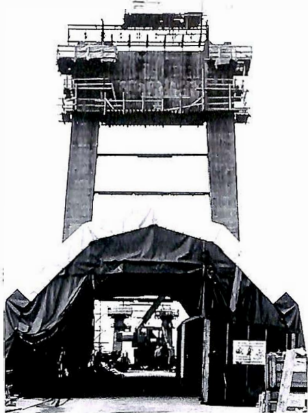
Bileta av Haglesundet bru er tekne i oktober. I dag vil nok situasjonen vera litt annleis, av di betongarbeida skal vera avslutta no.
