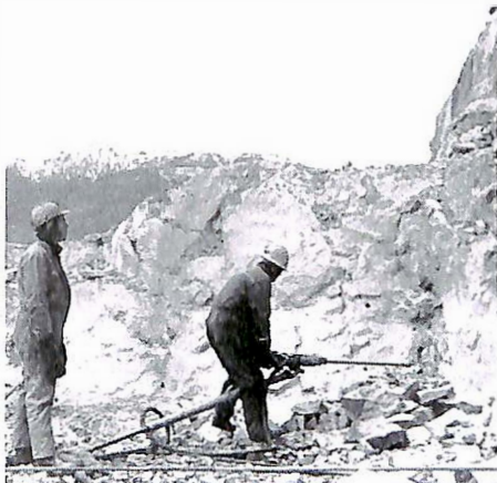
Den siste nabben på Masfjordvegen var hard å få bukt med, og handboring måtte til på grunn av det dårlege fjellet. (Foto: Røa)
