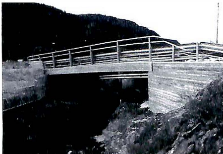
1: Fotlandsvåg bru (Fotos: J O S)
