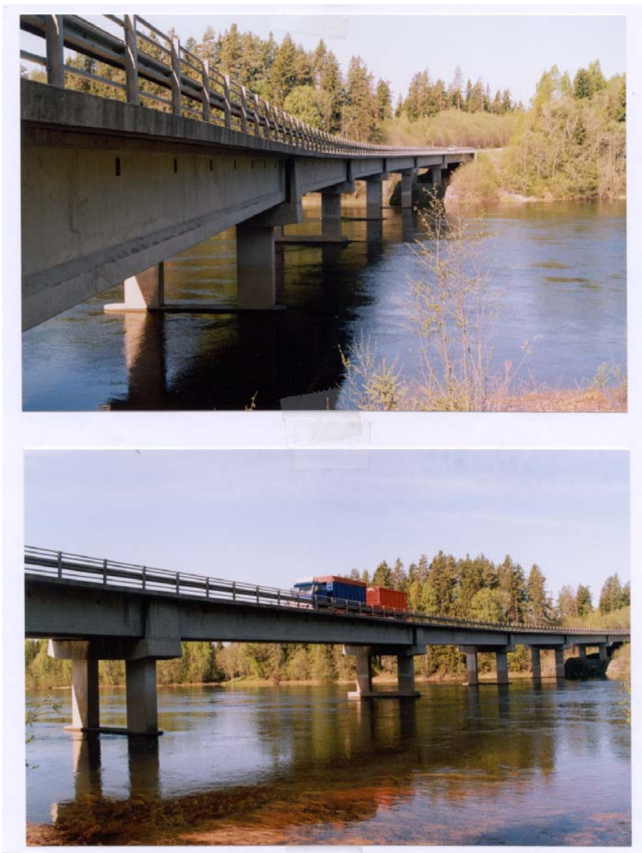
Enkel og harmonisk elementbru
