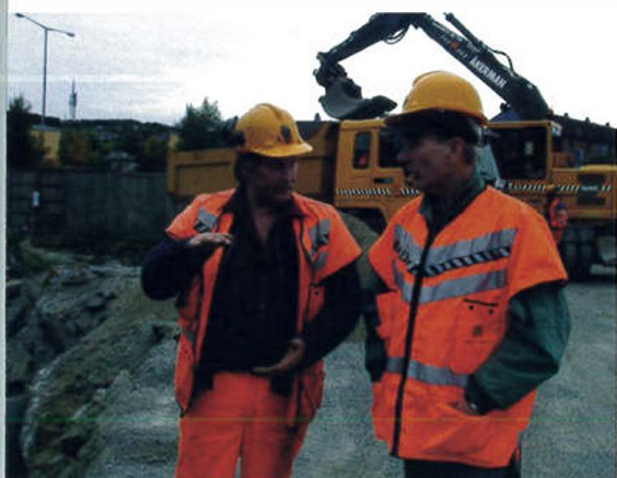
Tom Martin Espeland diskuterer arbeidet med bussgata med prosjektleiar Gunnar Nærum.
