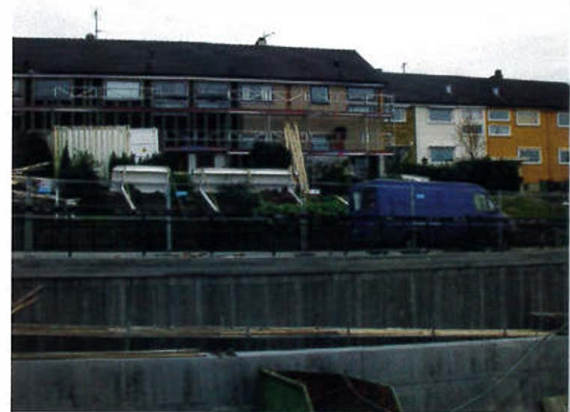
Omlegginga av busstraseen har ført til omfattande arbeid med fasadeisolering av husa nærast motorvegen.
