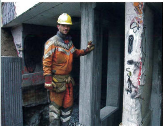
Karl Riska viser den nye og gamle muren i bussgata under motorvegen.
