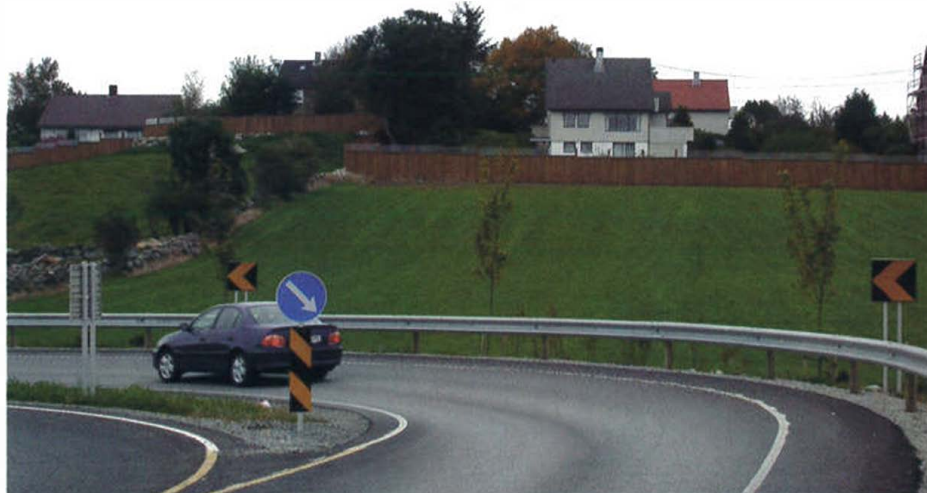
Her viser nokre av dei åtte støyskjermene som er sett opp rundt Solasplittkrysset. Landøy sitt hus heilt til venstre.
