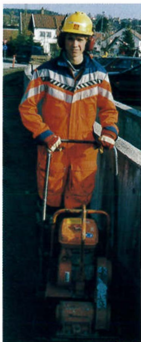
Karl Magnus Lausund i arbeid med komprimering av massen på det eine fortauet.
