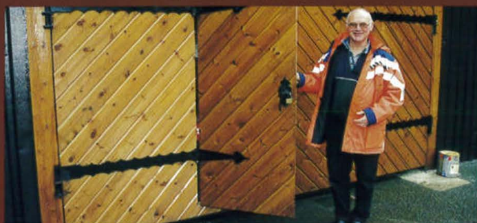
Museumsansvarleg i Dirdal, Martin Nødland, har smidd jernbeslaga på dørene til dei nye lagerbygga.
