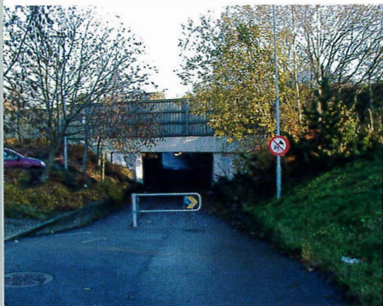
Nåverander gang- og sykkelveg under E 39 i Oscar Wistingsgate. Ved ombygging til bussgate blir vegen senka. Den nye gang- og sykkelvegen skal gå i eit eige siderom til venstre for undergangen.
