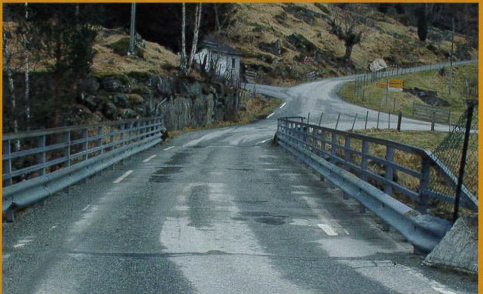
Hønsbærhaugen bru på fylkesveg 691 på Nesflaten.
