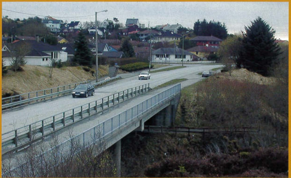
Kvalaelva bru på fylkesveg 924 i Hangesund.
