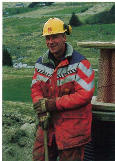
Jan Helge Tickner i arbeid på anlegget.
