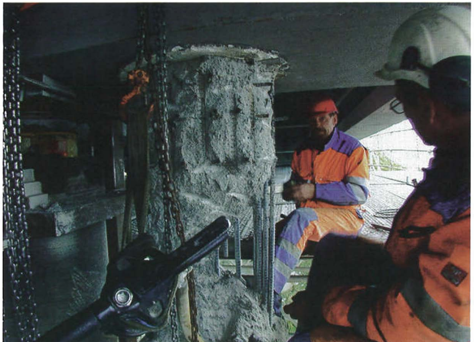
Frå arbeidet med å fjerna ei av dei gamle søylene. Brua blei først jekka opp. Deretter tok ein bort den gamle søyla for så å støypa den nye.
