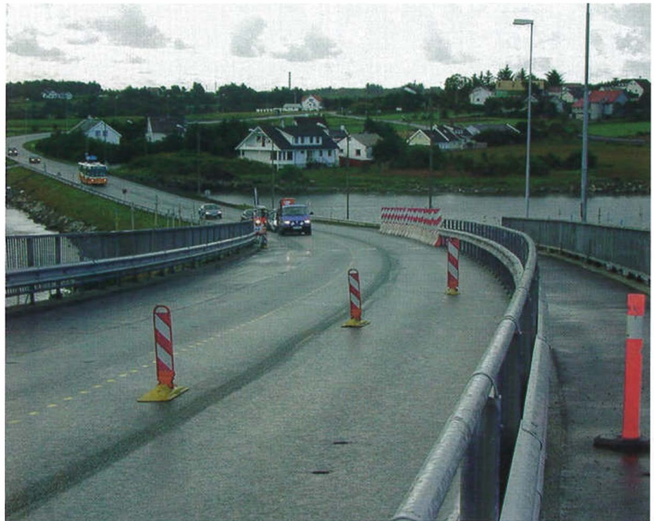
I samband med rehabiliteringsarbeidet er det også bygt gang- og sykkelveg over brua.
