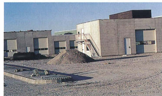
Tre kontrollhaller ligger på rekke og rad med et sinnrikt vegsystem for at trafikken skal gli godt, og mottaket gjøres enklere. Her er to av hallene.
