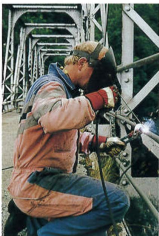
Øystein Kvalvik i arbeid med å reparera rekkverket.
