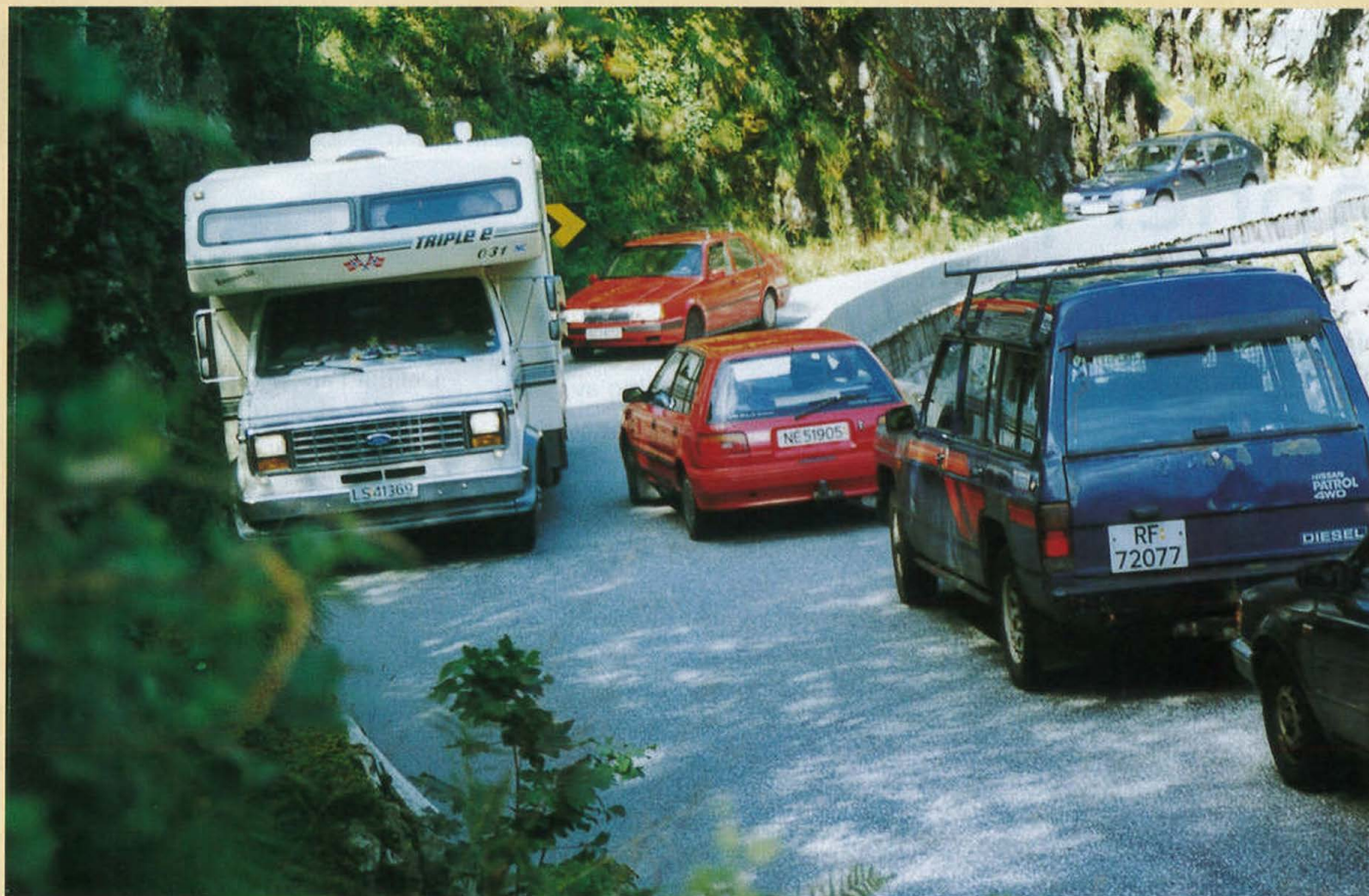
Vegen i Giljajuvet er mellom dei dårlege strekningane på riksveg 45.
