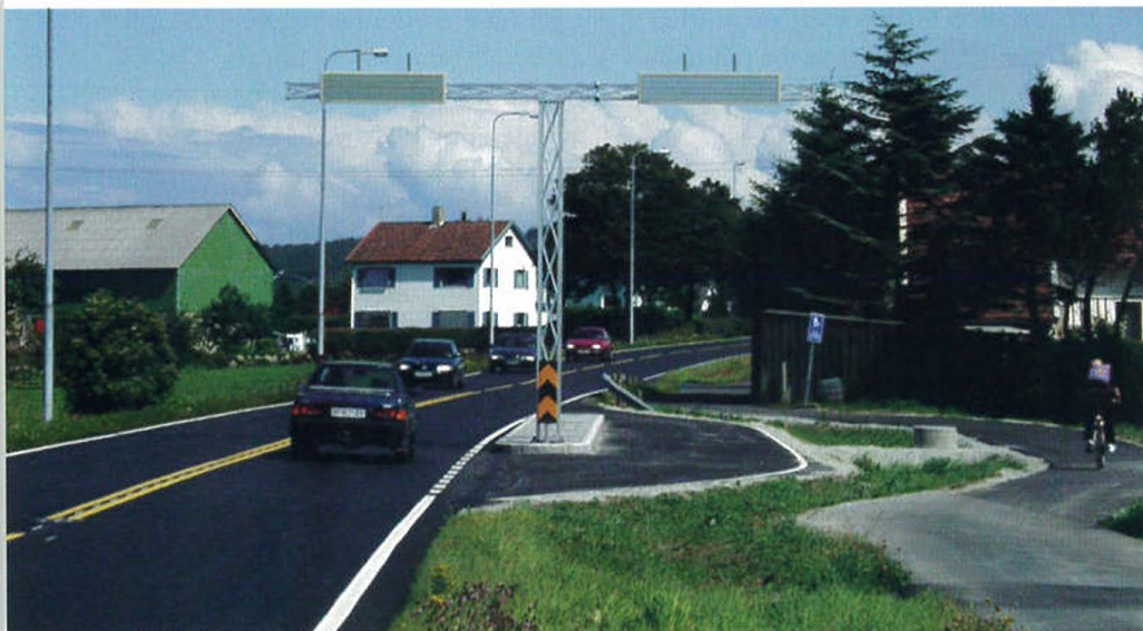
Her bygges bomstasjonen på Nesbuvegen i Stavanger kommune.
