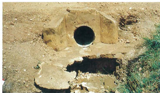
Stikkrennene er jamt over elendige. De menneskelagde rennene kan ofte være dårligere enn naturmetoden.
