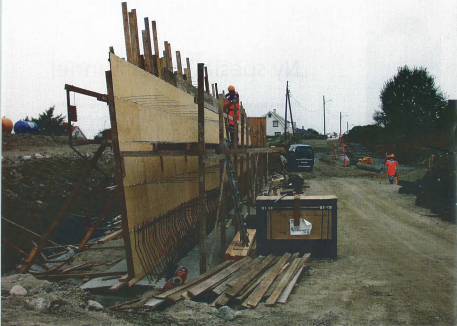
Sverre Hellenen setter opp forskaling til kulverten i Prestegårdsvegen. I bakgrunnen holder Trygve Petter Nilsen på å sette ut punkter.
