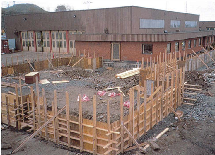
Tilbygget til kontordelen forskales og fundamenteres.
