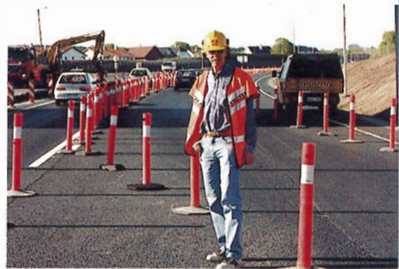
Odd-Magnar Nerland ved Lurakrysset. Me ser her litt av den omfattande skiltinga i samband med anleggsarbeidet. Det er kjøpt utstyr for 1,5 mill kr til skilting og varsling. Ingen ulykker under anleggsperioden, tyder på at dette er vel brukte pengar.
