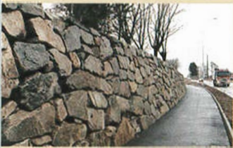
Langs ein del av den nye gang- og sykkelvegen er det bygt natursteinmurar.
