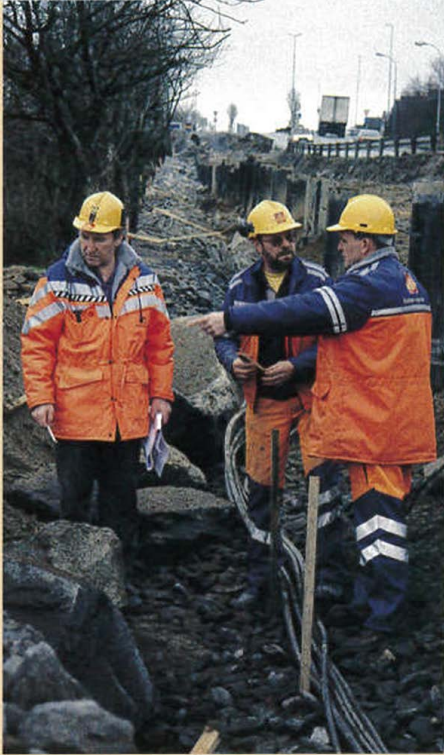
Samråding i grøfta, der den nye gang- og sykkelvegen gjennom Åsedalen er under bygging. Byggeleiar Per Eikemo (t.v.), anleggsformann Oddmund Mellomstrand og kontrollingeniør John Reidar Gard.
