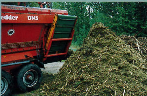
Kverna materiale etter skogrydding for trase til ny E 143 i Telemark.
