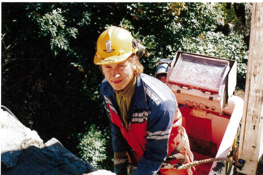
Jonny Stenberg gløtter opp over brukanten, mens han fra korga arbeider med å restaurere den kunstferdige natursteinmuren som brua er bygget av.
