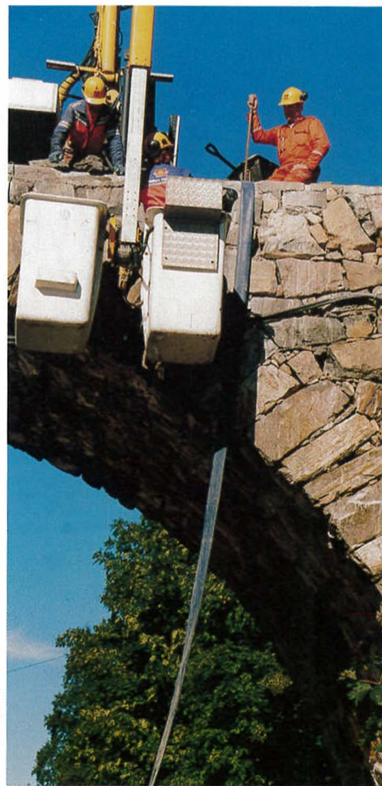
Fra arbeidet med restaureringa av brukvelven og natursteinmuren. I korga arbeider Jonny Stenberg, mens Einar Solli og Rolf Warland hjelper til fra brukanten.
