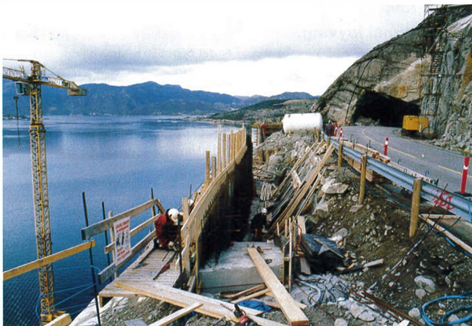
Fra bygging av støttemur ved Nibå på nordsida av Lysefjorden.
