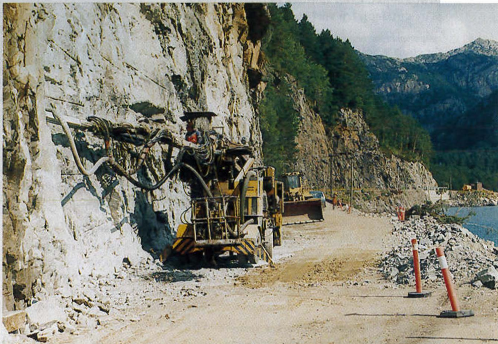
Frå arbeidet med å sikre veggen ved Hofreista.
