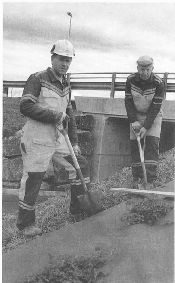
Sverre Hellen og Torleif Samsonsen i arbeid med siste finpussen, planting av skråningane ned mot gang- og sykkelvegen og undergangen. Murane inn mot undergangen er bygde i naturstein.
