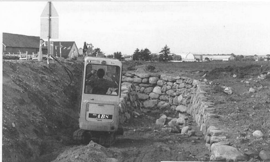
Nær Bore Samfunnshus er det bygt undergang der gang- og sykkelvegen kryssar riksvegen. Murane fram til undergangen er bygt i naturstein.
