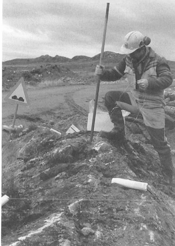
Roy Johannesen med dynamitt og ladestav, gjer klar til å sprenga vekk ein fjellknaus ved Matningsdal.
