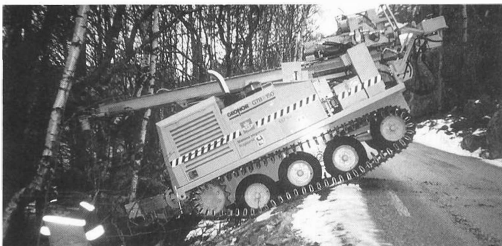
Med fjernstyring har man god og sikker framkommelighet i ulendt terreng
