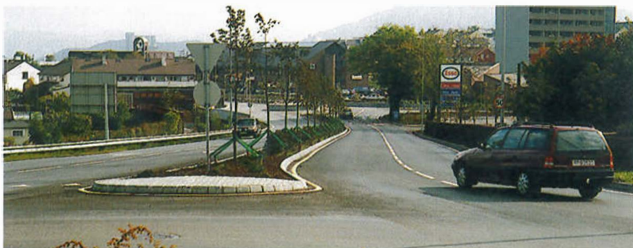
To store asketrær stod midt i vegtraseen ved Essostasjonen i Bekkefaret. Vegtraséen ble flyttet for å ta vare på disse trærne. Ellers har vi bygd en støttemur for å beholde et stort tre ved sjukehuset.
