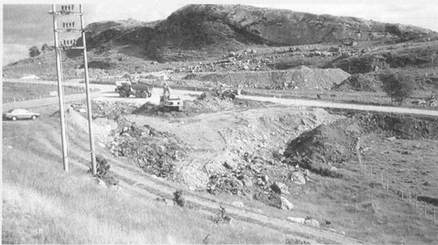
Fyllingsarbeider for nytt toplankryss i Våg.
