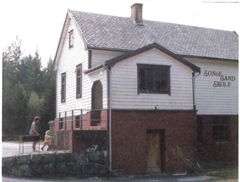
Songesand skule var i drift til 1990. Nå fungerer han som grendahus og bibliotek, som har ope ein gong i veka. Lærarbustaden som ligg like ved, blir brukt til turiststasjon.
