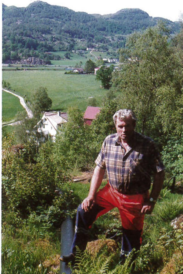
Tor ved rørgata på 90 meter som fører vatn frå bekk til kraftverket - som er skjult mellom trea - like ved huset på Birkeland.
