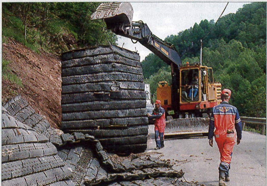
Ladinga er ferdig og bare tildekking og sikring står att før salva kan fyrast av. Maskinførar Einar Solli heiser gummimattene på plass etter instruksjon frå Torbjørn Hellenen (t.v.) og Arvid Stølen.
