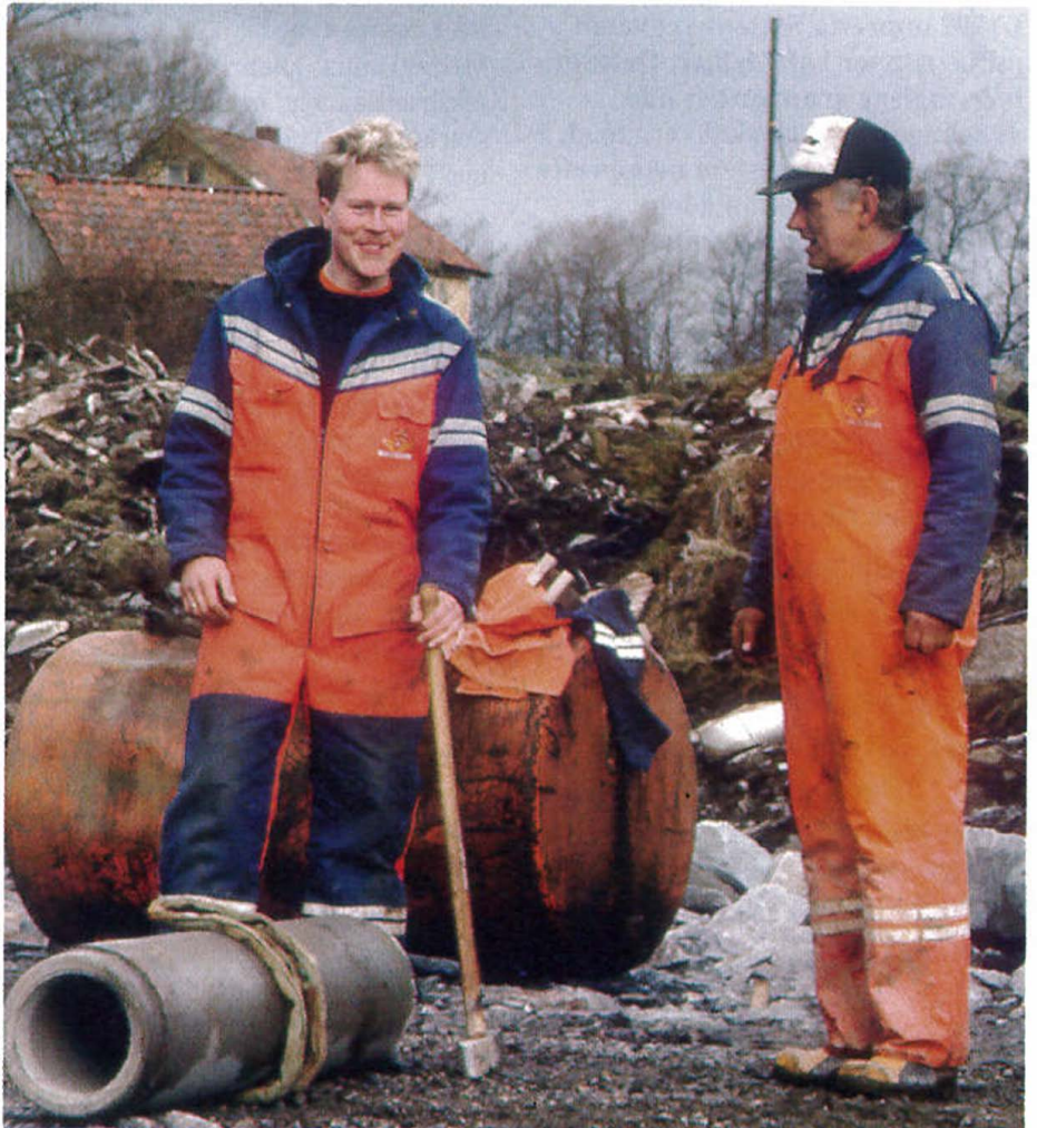
Vassledningar, kablar, rør og stikkrenner er ein arbeidskrevande del når ny veg skal byggast. På Rennesøy er det utført mykje arbeid for kommune, e-verk og televerket. Her er Roger Steinsland og Laurits Thorsen i arbeid med å leggja dreneringsrør.
