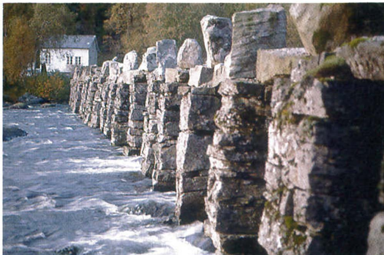
Terland klopp er ei steinhelle-bru på 60 meter fordelt på 21 spenn. Ho er ca 200 år gammal, og den lengste steinhellebrua som er bevart i Norden. Brua representerer ein enkel, men solid byggekunst som blei mykje brukt i tidlegare brubygging.
