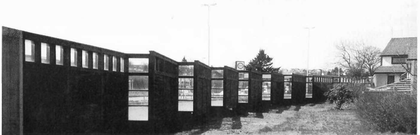
Støyskjermer langs den nye ve-gen, sett fra hagesida. Bruk av glass for å begrense høydevirkningen gir en god estetisk effekt.
