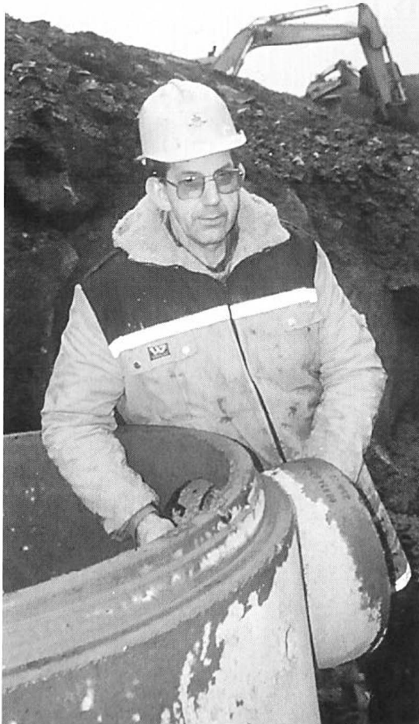
Nils Krokedal i arbeid med dreneringssystemet på vegganlegget Nordbø - Hanasand på Rennesøy.
