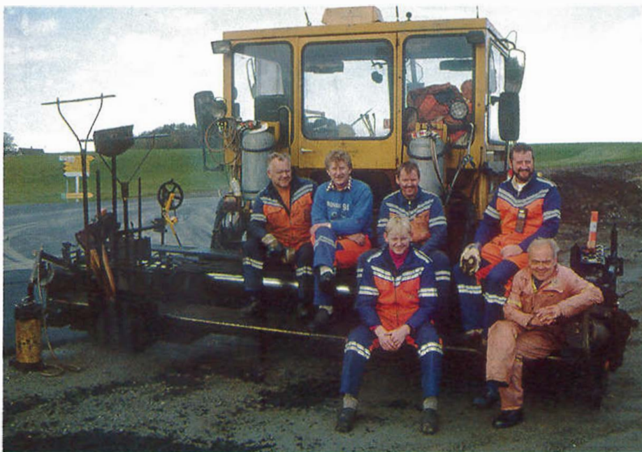
Arbeidet bak Rennfast er utrolig mangesidig. Asfaltarbeiderne til Statens vegvesen er blant dem som stod hardt på i den siste fasen av anleggsperioden. Bak fra v.: Randulf Dirdal, Geir Narvestad, Tor Skårland og Ole Tamburstuen. Framme: Arne Magne Sleveland og Stein Oftedal. (Foto: Torleiv Haugvalstad)
