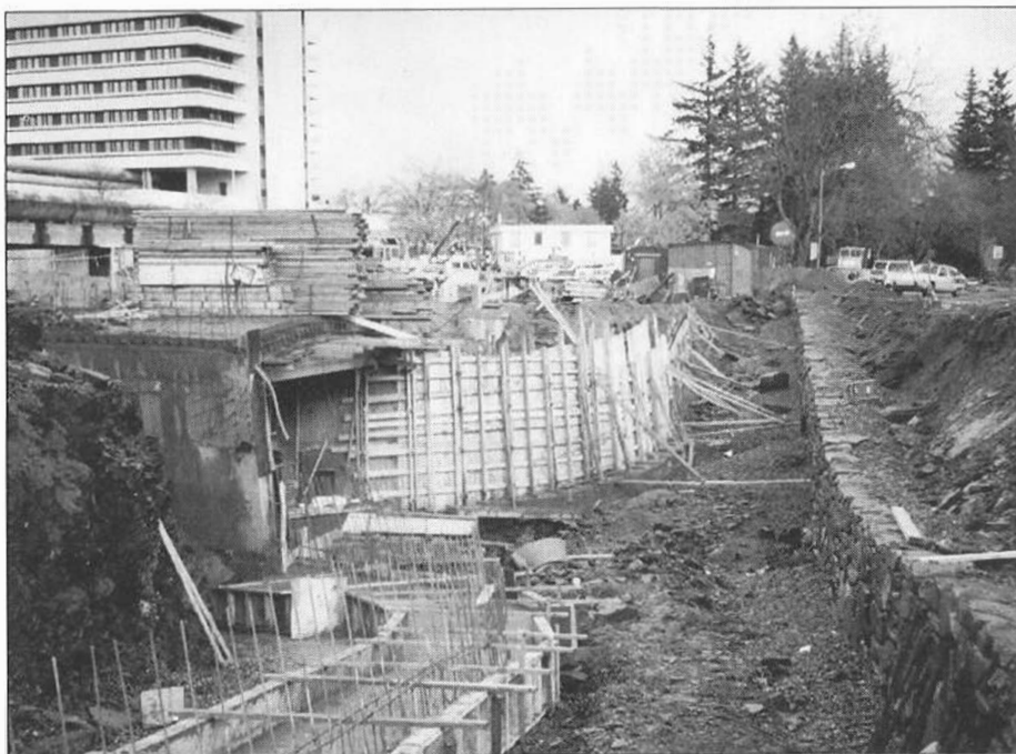
Rv.1 frå E18 - Motorvegen til Rv.44 i Hillevåg blir det største anlegget i 1993, finansiert med statlege midlar. Her frå arbeidet ved Sentralsjukehuset i november 1992. (Foto: Synnøve Helland)
