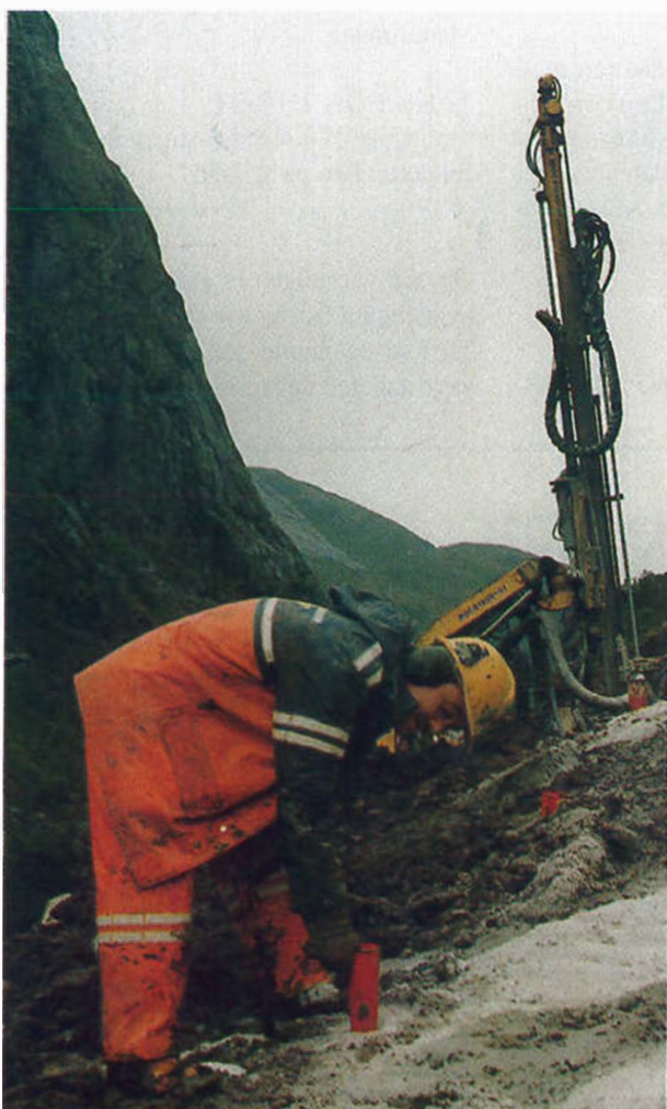
Roy Johannesen markerer borehola etter at han har fare fram med riggen og "lagt grunnlaget" for ei ny storsalve.
