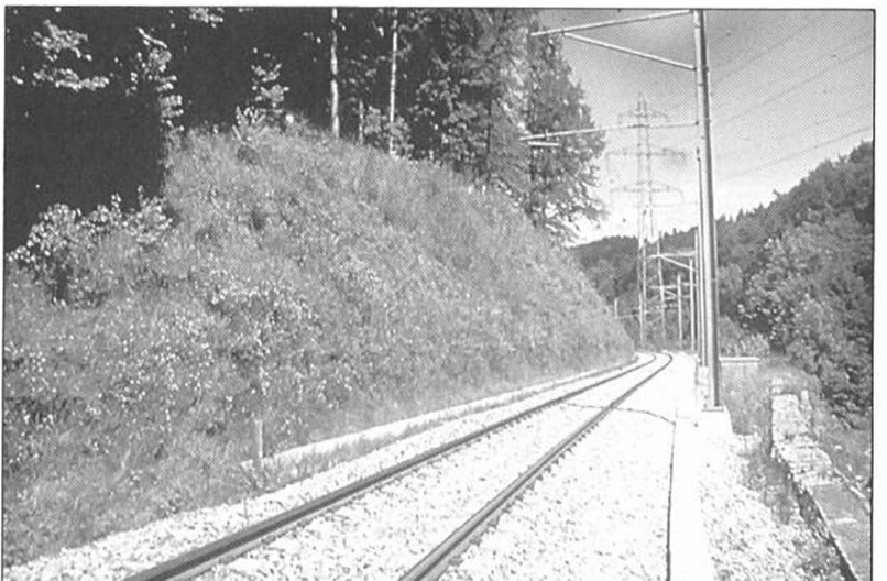
Textomur før og etter beplantning. Vi ser at skråningen er veldig bratt, men etter beplantning glir den naturlig inn i terrenget. Bildene er fra Sihltal utenfor Zürich.
