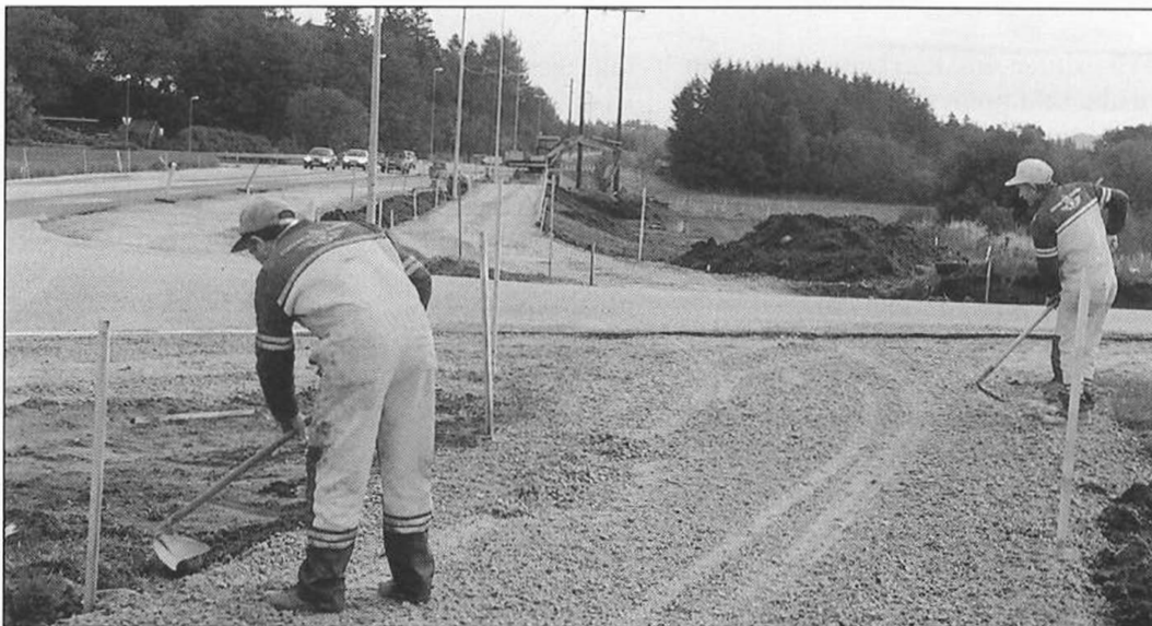
Magnus Danielsen og Erik Soma i arbeid med den siste finpussen før asfalteringa av det omlagde og kanaliserte krysset på Øksnevad.
