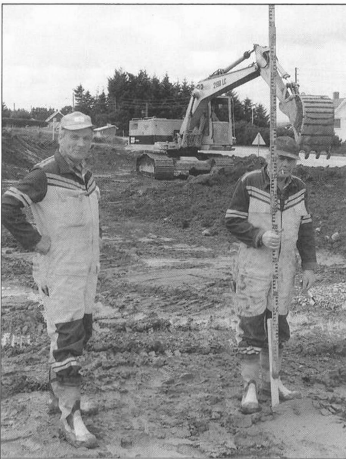
Petter Vik (t.v.) og Jørgen Lund under anleggsarbeidet på Veasletta.
