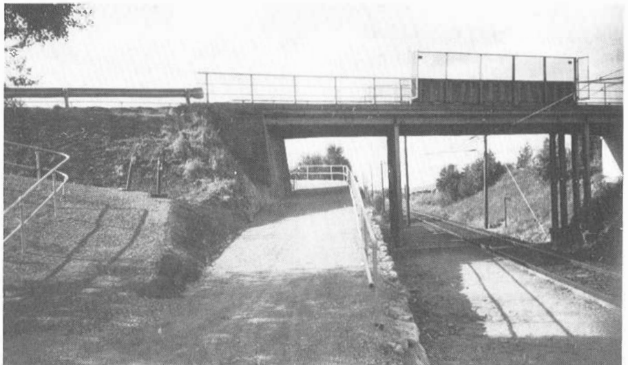
Ved Øksnevadporten har vegvesenet bygt rampe frå gang- og sykkelvegen ned til stasjonsområdet. Her er arbeidet nesten ferdig. Bare asfalten manglar.
