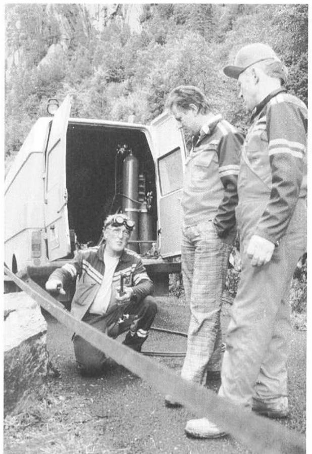
Asbjørn Tobiasen, Statens vegvesen Vest-Agder (t.v.) og Vermund Birkeland i arbeid med montering av smijernsrekkverk. Arbeidet blir drøfta med oppsynsmann Levy Dalen, som står mellom dei to.
