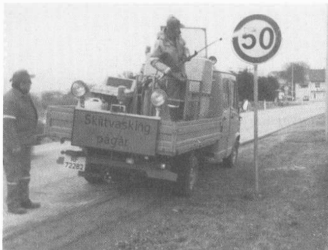
Skiltvask etter den gamle metoden ble utført med håndholdt redskap frå pick-upens lasteplan.
