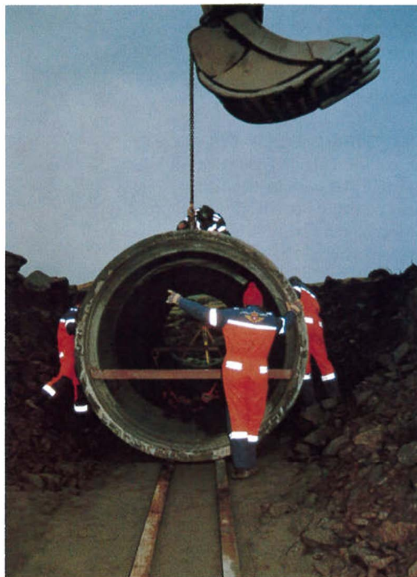
Det bygges flere underganger på strekningen Bergje - Ertenstein. Det brukes ferdigelement som blir løftet på plass med gravemaskin. Nederst tar Erik Fjermestad, Paul Stranden og Geir Gudmestad en pust i bakken etter at et rør er kommet på rett plass
