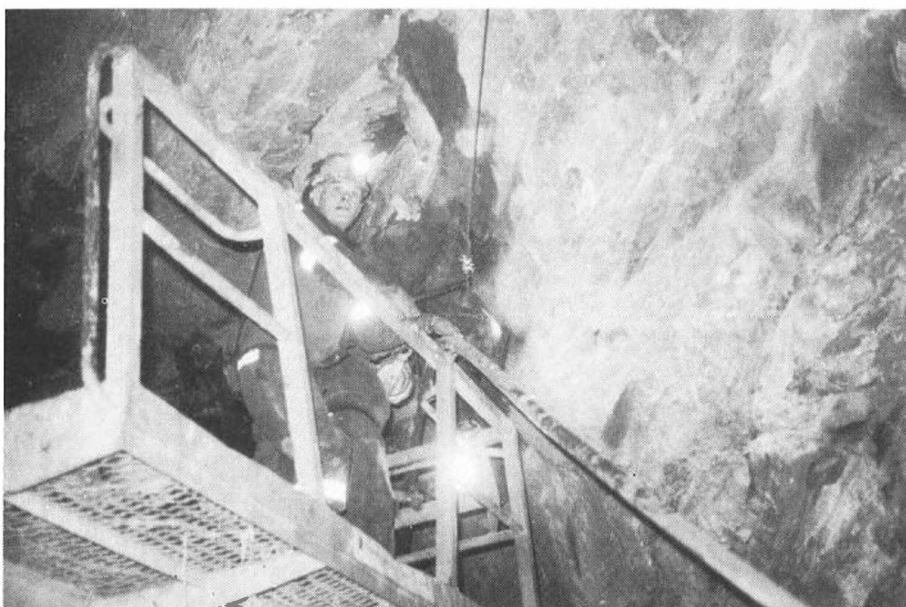
John Haugslund på opprenskningsarbeid etter at ei salve er sprengt.
