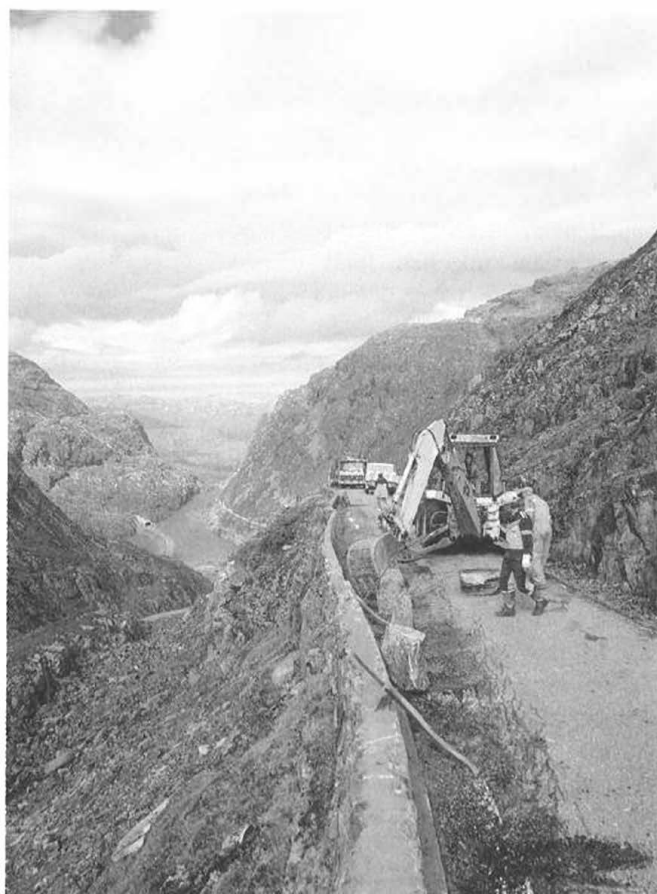
Frå restaureringsarbeidet på den gamle E 76 over Røldalsfjellet. Vegen går gjennom vakker natur og har praktfulle utsynspunkt. (Foto: Erling Grønsdal)
