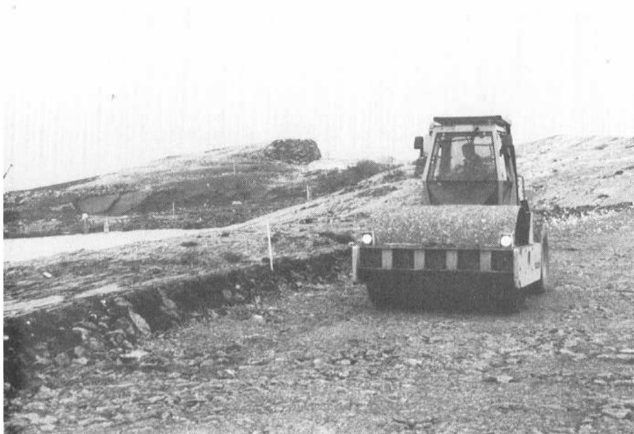
Fra anleggsarbeidet ved Are på Bokn. I bakgrunnen til venstre er ferjestøa i Arsvågen med oppstillingsplass, under arbeid. Nesten en tredjedel av anleggsmidlene for 1991 går til ferdigstillelse av Bokn-prosjektet. (Foto: Harald Sel)
