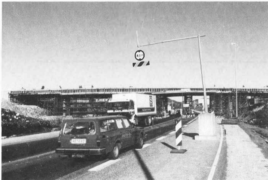
Frå arbeidet med den nye brua over motorvegen på Lura.
