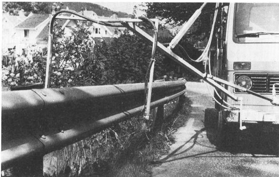
I dag blir kjemisk sprøyting langs vegane stort sett avgrensa til under rekkverk. Innan 4 år skal også denne vegetasjonen ryddast mekanisk eller manuelt.
