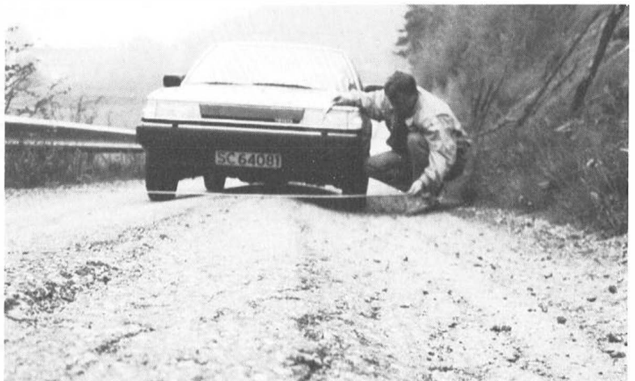
Omlag som dette ser dekket ut på stadig større del av fylkesvegnettet. Her er oppsynsmann Helge Bakka i arbeid med å registrere "elendigheten" på Fv.689, Littlehaga bru - på veg til Grov i Suldal.
