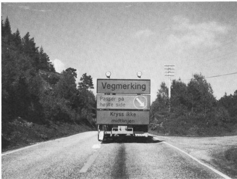
Vegmerkebil i arbeid. I Rogaland brukte ein i fjor 96 tonn løysemiddelhalddig vegmerkemaling. Av dette forsvann 34 tonn i atmosfæren.
