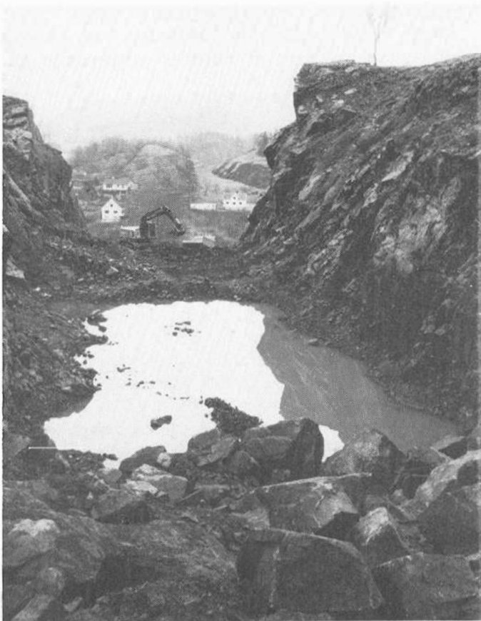
Store steinmassar er sprengt bort, og den største skjeringa er 18m høg. I bakgrunnen ser me Tothammer.
