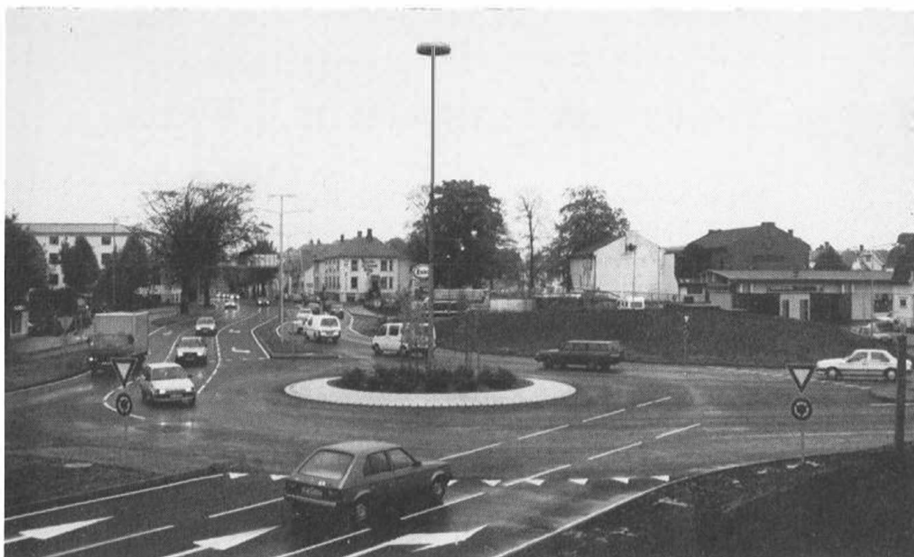
Krysset Motorvegen/Madlavegen ble ombygt til rundkjøring i 1989. Sammen med stenging av Wesselsgaten, forventer vi en betydelig reduksjon i ulykkene på denne strekningen av Madlavegen.
