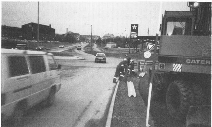
Montering av rekkverk ved ny rundkjøring i krysset Karmsundgt. - Storesundgt.
