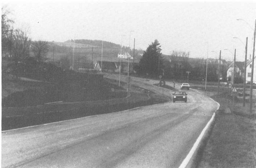
Ved siden av gang- og sykkelvegen, er det utført ein del utbetrings- og trafikkteknisk arbeid. Biletet viser krysset med fv 374 (Nordsjøvegen) som er ombygt og kanalisert.
