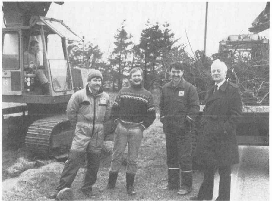
Dette biletet er frå rv 505 ved Nærbø, under dugnadsarbeidet. Frå venstre: Odd Magnar Undheim (i gravemaskinen), Bjørn Friestad, Kåre Qvalbein, Bernt Hegrestad og ordførar Kjell Lund.
