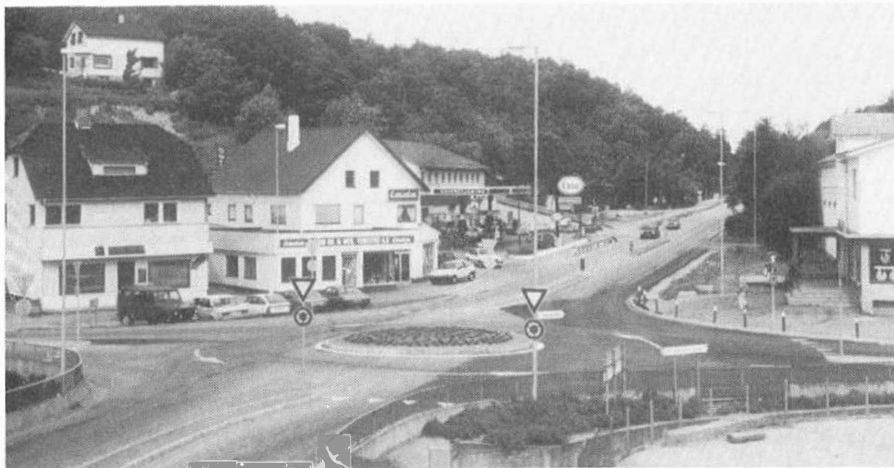
Rundkjøringa i Meierikrossen på E 18 i Ålgård sentrum. Vegen har stor trafikk og krysset var tidligere sterkt ulykkesbelasta. Dette har bedra seg betydelig etter at rundkjøringa ble bygt i 1987.
