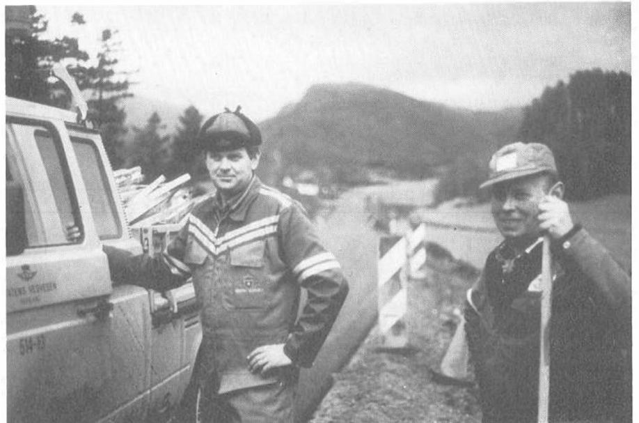
Her ser me ein del av den vegstrekninga som er utbedra med retning mot Hestad. I framgrunnen 2 av arbeidarane på anlegget, Kjell Narvestad (i.v.) og Harald Espevik.
