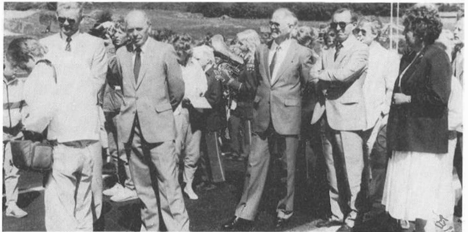
Ordfører Hans Sund, lengst til venstre, har nettopp foretatt den offisielle åpningen av toplankrysset på rv 14 ved Håvik.
